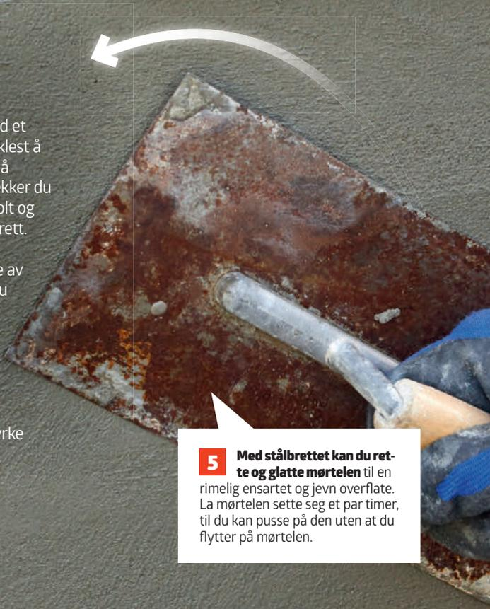
**5** Med stålbrettet kan du rette og glatte mørtelen til en rimelig ensartet og jevn overflate. La mørtelen sette seg et par timer, til du kan pusse på den uten at du flytter på mørtelen.
