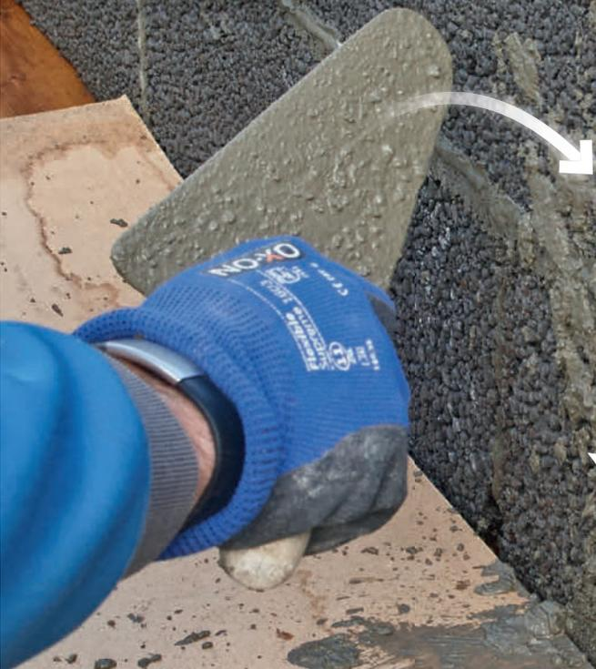
**3 Mureren kaster mørtelen på sokkelen:** Løft opp et lag mørtel på en murerskje, og send den tynne blandingen i retning av sokkelen med et håndleddkast. Det krever litt øvelse.
