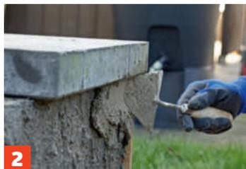
**2** Begynn med å tette grundig opp under kanten mot fasaden, der det kan være vanskelig å trekke sammen mørtelen med pussebrettet. Da blir det en helt tett overgang til fasaden.
