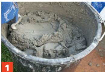
**1** Bland mørtelen etter anvisningen på posen til en kremet, homogen konsistens. Rør godt i 5-15 minutter. Bland kun mørtel til 45 minutters arbeid om gangen.
