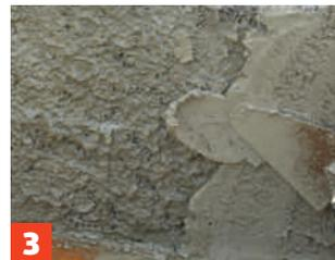
**3** Trekk på mørtelen med en murerskje. Mørtellaget kan gjerne være litt for tykt. Trekk på én meter om gangen.
