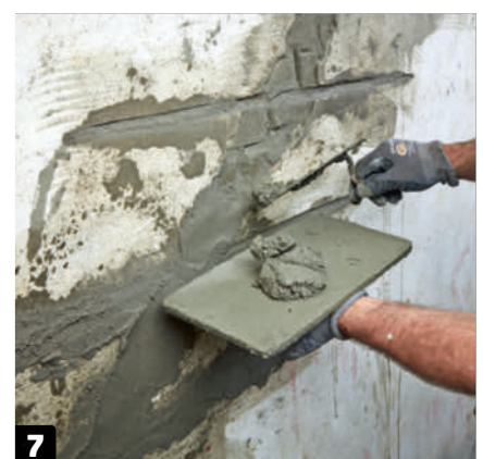
7 Bruk en større murerskje til de større flatene som skal fylles opp med mørtel. Legg på mørtelen så jevnt som mulig.
