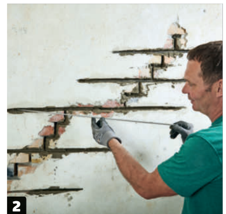
2 Fyll flislim i de lange fugene, og legg på plass stålstengene. Flislimet føres inn i bunnen av fugen med en smal fugeskje. Deretter legges stengene inn.
