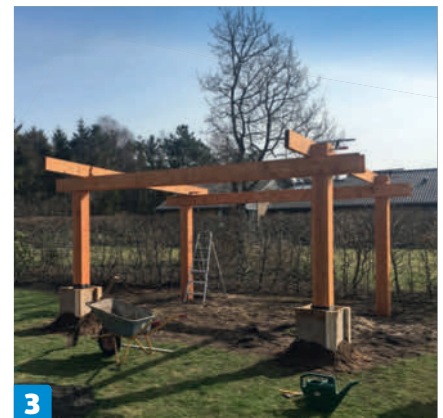
3 Legg på toppsvillene, og støp betongføtter på de fremste stolpene. Formene plasseres og fylles med betong. Svillene er dobbelte på både de fremste og bakerste stolpene, og festes med to bolter på hver.
