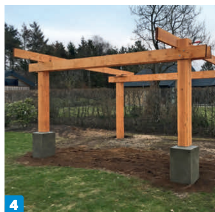
4 Fjern støpeformene etter 1-2 dager, men de skal stå minst fire uker før de kles med stein. Her er det laget en skrå kant øverst på betongføttene, så vann kan renne vekk.
