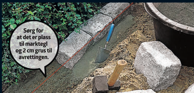
4 Når du har funnet bredden, kan du trekke en murersnor og legge resten av granittsteinene. Rett deretter opp avrettingslaget, slik at det heller 1-2 centimeter per meter ut mot veien.
