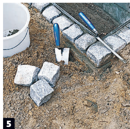
5 Legg brostein rundt lyskassen, før den lukkes med en rist. For å være helt sikker på at steinene blir liggende, lager vi en kantstøp. Til formålet lager vi en blanding av 1 del sement og 5 deler støpesand.
