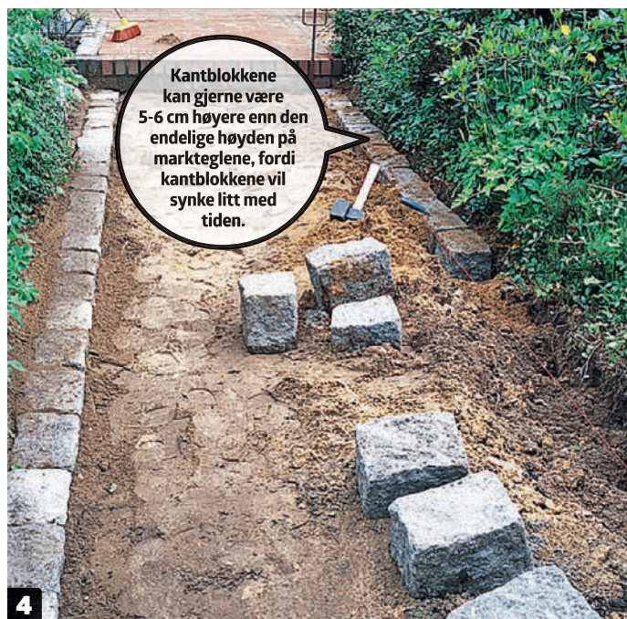
4 Når du har funnet bredden, kan du trekke en murersnor og legge resten av granittsteinene. Rett deretter opp avrettingslaget, slik at det heller 1-2 centimeter per meter ut mot veien.
