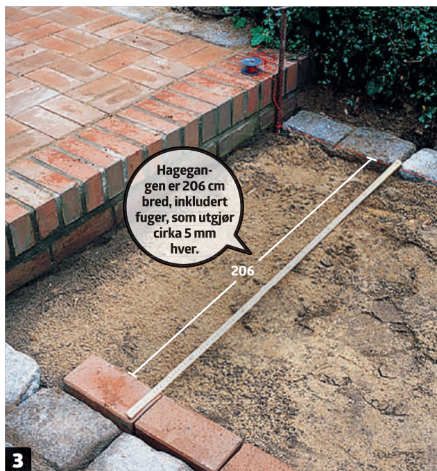
3 På arealet til selve stien sjekkes det at bredden går opp med det antallet steiner du har tenkt å bruke. Med riktig planlegging unngår du å tilpasse steinene med en vinkelsliper.
