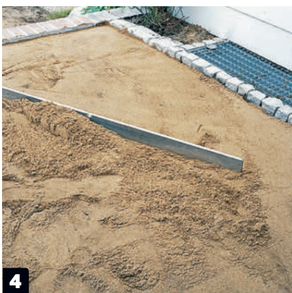
4 Rett opp gruslaget med et langt bord eller en rettholt. Det er viktig at gruslaget faller 1-2 cm per meter ut mot gaten, slik at regn og nedbør ledes vekk fra huset.
