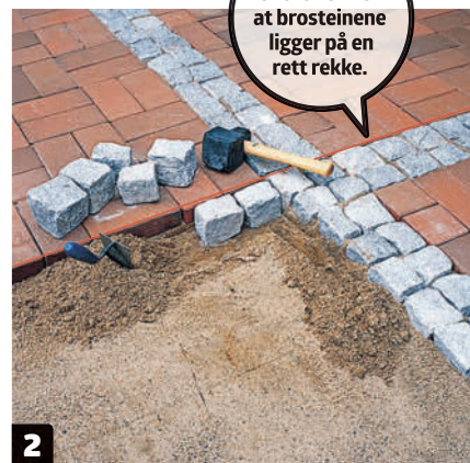
2 Legg to rekke brostein som et kryss, og fyll deretter opp med marktegl. Det er viktig at krysset er vinkelrett, slik at teglene ikke blir "tvunget" ut av vinkel. Det vil i så fall ødelegge symmetrien.
