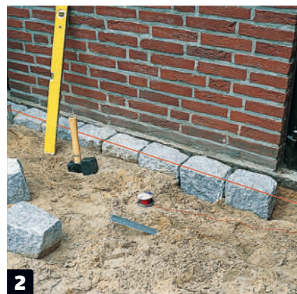
2 Slå fast brosteinene i underlaget med en gummihammer, og bruk en murersnor og et vater til å forsikre deg om at steinene ligger helt rett og ikke varierer i høyden.
