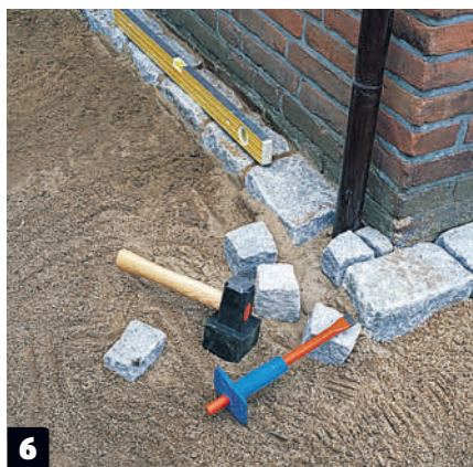
6 Er det behov for tilpassinger, hugger du av brosteinene med hammer og meisel. Her legger vi små steiner rundt et nedløpsrør, slik at de dekker området best mulig.
