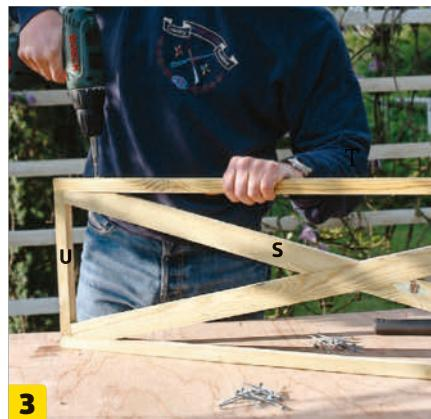
**Sett kryssene i rammene.** Skru dem fast i hjørnene som vist med 4 x 40 mm skruer.
