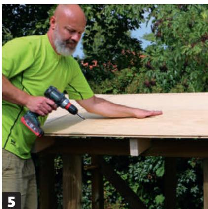
**Takplatene skrues på,** etter at de er skåret til. Utstikket er 40 cm på alle sider. I dette tilfellet blir hver side 147 x 347 cm. Platene er også skåret skrått på 10 grader i toppen.
