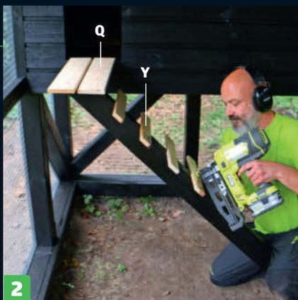
**Lister (Q og Y) monteres som plattform og trinn,** når stigen er malt. De skytes fast med en spikerpistol. Mellom hvert trinn er det et mellomrom på cirka 15 cm.
