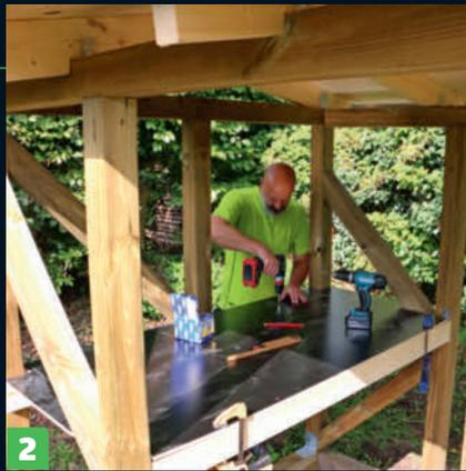
**2** **Bunnplaten monteres.** Den lages av en robust forskalingsplate og sages til med en stikksag, slik at den passer rundt stolpene. Du må forbore i forskalingsplaten før du skrur i den.
