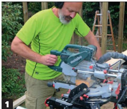
**Bjelkene (D) til den første sperren kappes** med en vinkel på 10 grader i den ene enden. Da blir vinkelen på taket også 10 grader.
