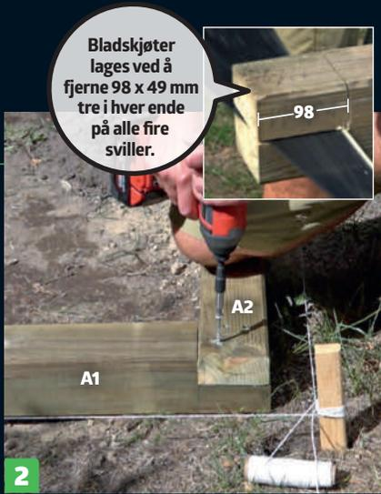
**2 Bunnsvillen settes sammen** av bjelkene (A1 og A2) med skruer (5 x 90 mm). I forkant er bjelkene kappet til, og det er saget ut til bladskjøter i hjørnene.
