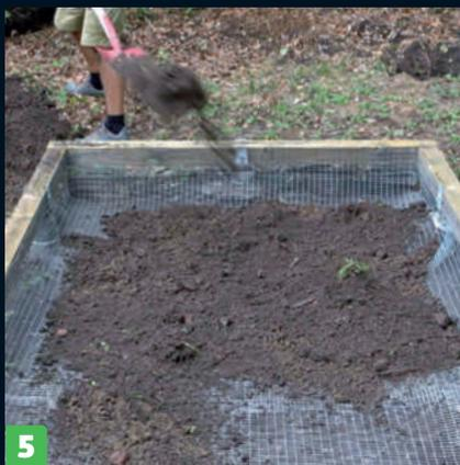
**5 Nettingen rulles ut i bunnen** med en overlapp på 10 cm. Overlappen sikres med ståltråd. Nettingen stiftes fast på innsiden av bunnsvillen, og bunnen dekkes med jord. Endene dekkes av bord (V1 og V2).
