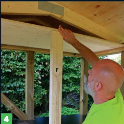
**4** **Takplaten monteres og understøttes av en stolpe (F),** som monteres med vinkelbeslag (50 x 35 mm) og beslagskruer. Denne platen er 160 x 77 cm.
