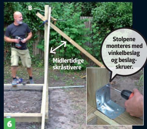
**6 De fire hjørnestolpene (B) settes opp.** De understøttes midlertidig med to tverrstivere. De settes fast til bunnsvillen med vinkelbeslag (105 x 90 mm) og beslagsskruer, etter at stolpene er i vater.
