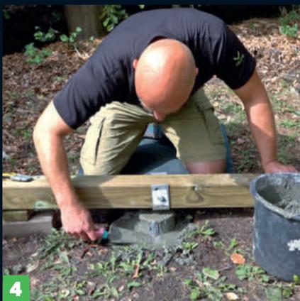
**4 Hullene fylles med tørrbetong blandet med vann.** En bit av et forskalingsrør holder den våte betongen over bakkenivå. Røret er skåret opp, så det kan komme rundt stolpebeslaget når betongen er tørr.
