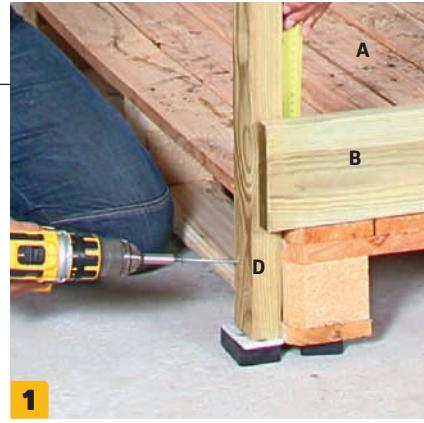
De to korte lektene (D) er skåret av i toppen med et 15 graders snitt. De monteres med tre 4,5 x 70 mm skruer. Terrassebordet (B) holder styr på konstrukasjonen og skal flukte med kanten på pallen.
