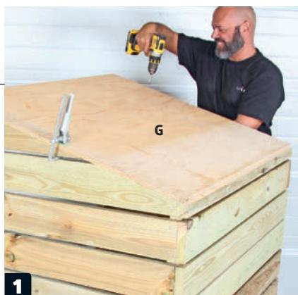
**Sag til taket (G).** Sag kryssfinérplaten, slik at den dekker hele taket. Legg den på toppen av vedskjulet. Fest den med en tvinge, og skru den fast med cirka 10 cm mellomrom mellom skruene.
