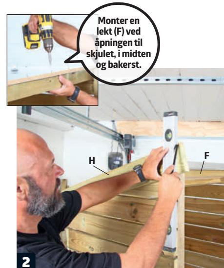
**Monter vindskiene (H).** Overkanten skal være 4 cm over taket. Hold et vater på vindskien, cirka 1,5 cm utenfor fasaden, og merk opp. Monter takfotbeslaget etter at vindskiene er skrudd fast.
