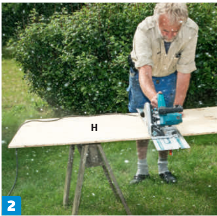
Gulvplaten (H) skjæres til. Fjern først noten på den ene kanten med en dykksag. Da får du en rett kant å måle ut fra. Sag til kryssfinérplaten så den passer til sokkelen.
