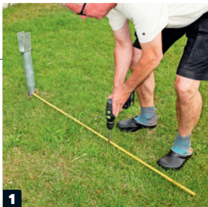
Mål ut til fundamentet. Forbor med et 12-15 mm murbor. Da er det enklere å få skruene ned i bakken.
