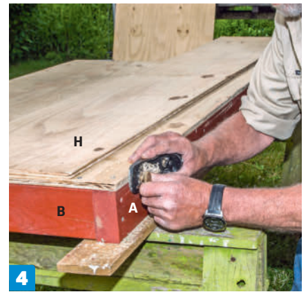
Kantene rettes til. Til slutt avfases kantene med en liten høvel. Kantene på platen males røde senere.
