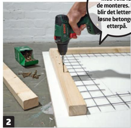
**2 Skru fast lekter til platen** hele veien rundt med 4 x 50 mm skruer. Lektene markerer størrelsen på benkeplaten. Skjær til et armeringsnett, som skal passe innenfor lektene. Det armerer og forsterker benkeplaten.
