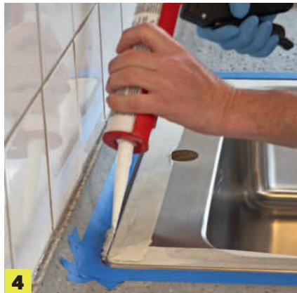
**Legg en silikonfuge rundt vasken.** Den skal sikre at det ikke siver ned vann mellom vasken og benkeplaten.
