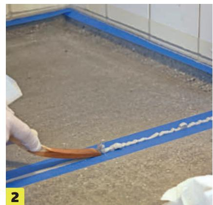
**Tett sprekk med silikon.** Våtromssilikonen tåler livet på kjøkkenbenken. Legg teip langs benkeplatekantene, og glatt fugen med en fugepinne eller -brikke. Gjør det samme langs kanten mot veggen.
