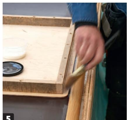
**Rammens ytterside skal lakkes.** Den får tre strok lakk, med tørkeperioder og mellomsliping mellom. Da unngår vi at den henger seg fast i betongen.
