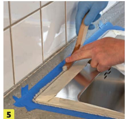
**Glatt fugen.** Bruk en fugepinne eller en fugebrikke av silikon til å glatte med; da får du et flott og glatt resultat.
