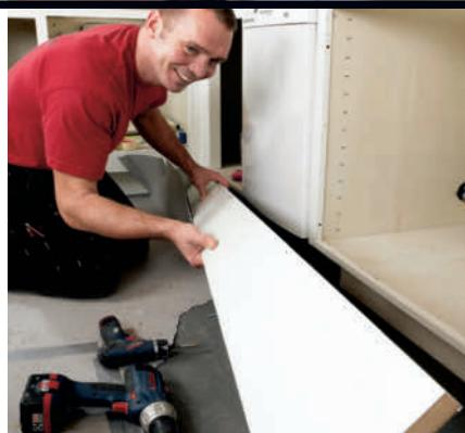
**1** En pyntesokkel tilpasses og skyves inn under underskapene. Sokkelen skal være så høy som mulig.
