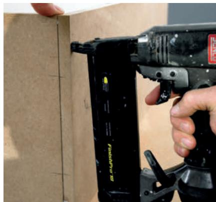
**4** **Bank eller skyt inn spikrene.** Med lim og spiker går det ikke i styrker. (En hammer er selvsagt god nok for å få spikrene inn.)
