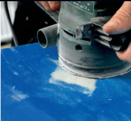
**1 Hull og hakk fylles** med formtre. Det er holdbart, det kan slipes, og når dørene er malt, kan det ikke ses at du har sparklet hullene.
