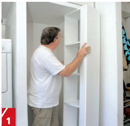
1 Den ferdige hylleseksjonen dyttes på plass og festes til veggen med tre vinkeljern og 5 x 40 mm skruer. VIKTIG! Tilpass hylla nede dersom det er gulvlister eller andre hindringer.
