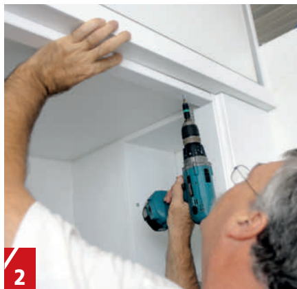
2 Anslagslister festes på undersiden av overskapet og på siden av veggen. De plasseres i flukt med framkanten av mdf-plata (C) og hindrer døra i å gå inn i skapet.
