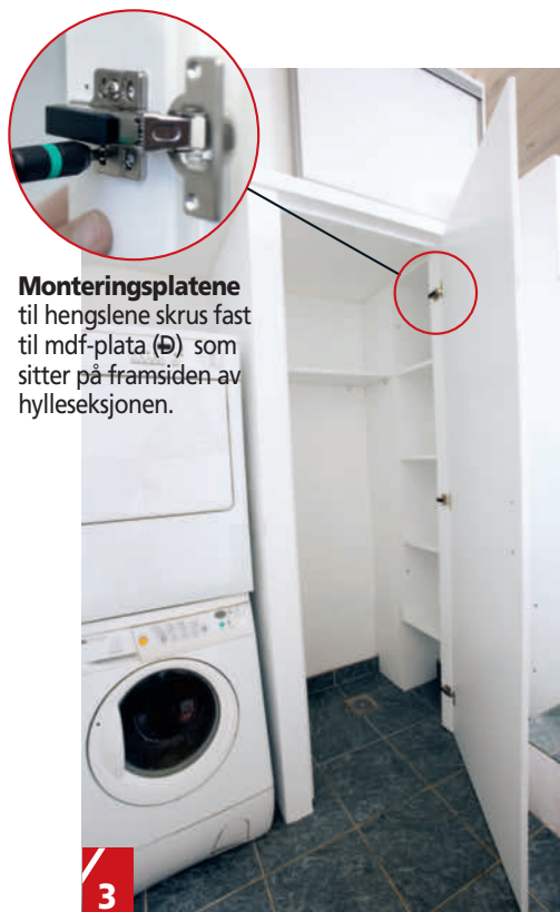
3 Den runde delen av hengselet plasseres i hull du borer i døra og festes med skruer. Den malte døra klemmes på plass, og justeres i lodd med justeringsskruene. Til slutt skrur du fast et håndtak på døra.
