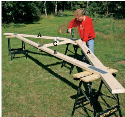
**4** Legg nå de fire delene på bukkene der de monteres med hullplater og beslagskruer. De nedre hullplatene er svært viktige for styrken og må festes ekstra godt. **VIKTIG!** De to takstolene til gavlene skal bare ha hullplater på den ene siden.
