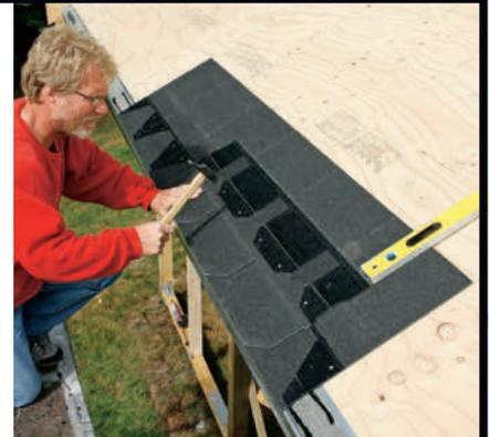
**2** Oppå begynnerlaget legges den første rekka med shingel. Legg den mot underkanten av aluminiumsbeslaget, og fest den med spiker på begge sider av de klebende feltene.
