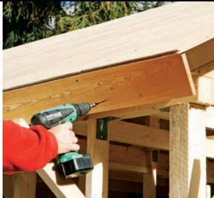
**1** Et framkantbord (F) monteres på takstolene med 4,2 x 55 mm rustfrie skruer. Montér også skruer gjennom kryssfinérplata og ned i framkantbordet.
