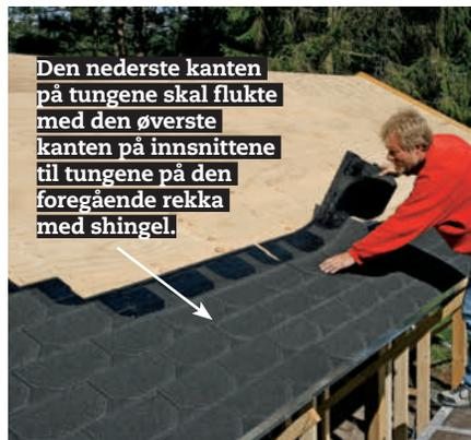
**3** De neste rekkene med shingel legges med 16,6 cm forskyvning. Det er lett å se, for de mørke, klebende feltene markerer hvor du skal legge neste rekke. Fest med spiker i de mørke feltene.
