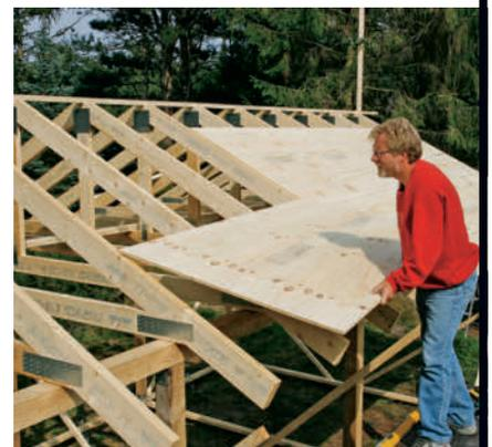
**8** Kryssfinérplatene sages til slik at de skjøtes midt over takstolene. La platene stikke 5 cm ut over endene på takstolene (raftet). Fest dem til takstolene med 4 x 60 mm skruer per 15 cm.
