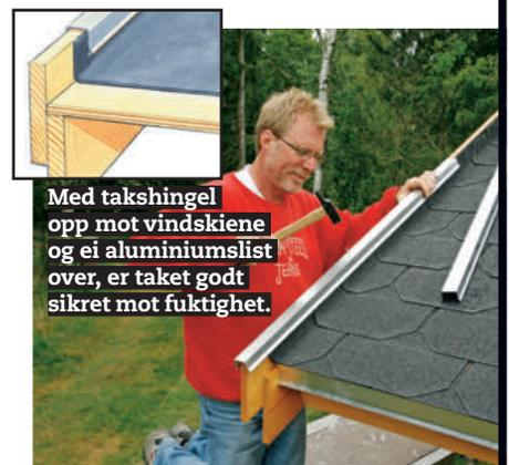
**7** Fest aluminiumslista på overkanten av vindskibordene. De skyves sammen og trekkes fra hverandre slik at de sitter med 2 mm avstand slik at det er plass til at de kan utvide seg i varmen. Fest dem med aluminiumsspiker.
