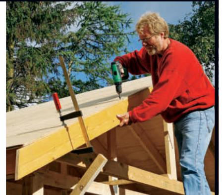
**2** Et vindskibord (G) festes gjennom kryssfinérplata med skruer. Spenn det fast med skrutvinger, mens du fester det. Skru det også fast til framkantbordet og mønelekta.
