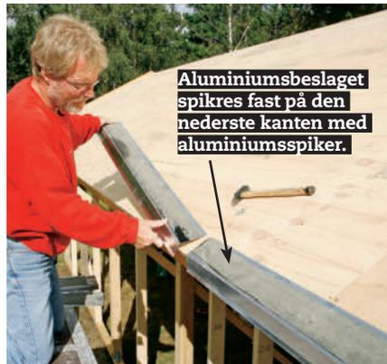
**4** Nederst på kryssfinértaket festes et aluminiumsbeslag som kan lede vekk vannet. Skyv beslagene sammen og trekk dem så et par millimeter fra hverandre. Da er det plass til at de kan utvide seg i varmt vær.
