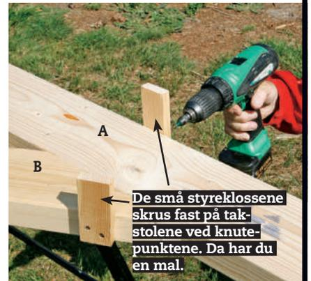
**5** Lag nå den første takstolen om til en mal. Snu takstolen med hullplatene nedover. Skru små styreklosser på kanten ved knutepunktene.
