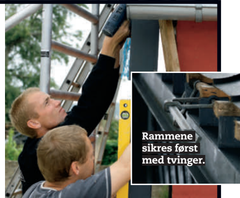
De to hullene bores slik at de passer med føttene på ramma.
