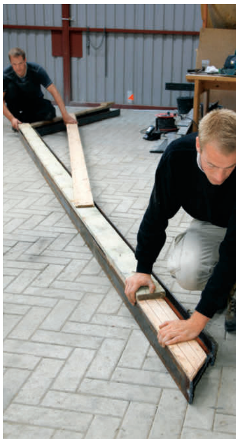
2. Stålprofilene legges ut etter en mal. Du kan også tegne opp malen med krittspor på gulvet.
