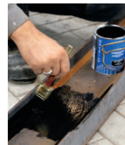
4. Sperrene avfettes og males med maling for stål, f.eks. Hammerrite.
