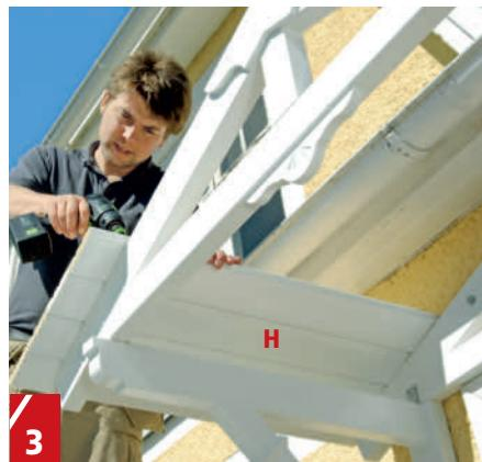
**3 Panelbordene (H) monteres med not og fjær og skrus fast** med skruer med selvforsenkende hoder. Da er det lettere å legge på takpapp. Det nederste bordet stikker litt ut slik at det dekker stussbordet (M).
