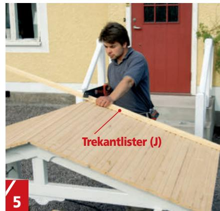
**5 Ta ned hele konstruksjonen** når du skal montere resten av panelbordene, trekantlister og takpapp. Trekantlistene (J) leder vekk vannet slik at det ikke kommer ned bak vindskiene og inn under takpappen.
