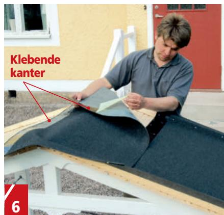
**6 Takpappen skjæres til i lengden.** Den er selvklebende i kantene. Begynn nedenfra, og fest den første banen med spiker langs den øverste kanten. Pass på at takpappbanene overlapper hverandre slik at vannet renner av.
