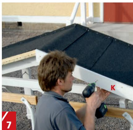
**7 Skru fast vindskeiene (K) på taket.** Bruk en smygvinkel når de skal sages til. Bord på 19 x 98 mm gir her harmoniske vindskeier. Montér et aluminiumsprofil (L) på vindska slik at det ikke kan trenge vann inn under takpappen.
