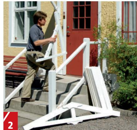
**2 Mal delene** før du setter dem opp. Bruk eventuelt kvistlakk til kvistene slik at de ikke kan ses gjennom malinga. Bruk grunning, og mal så med heldekkende treimpregnering. Når alle delene er tørre, setter du opp letaket.
