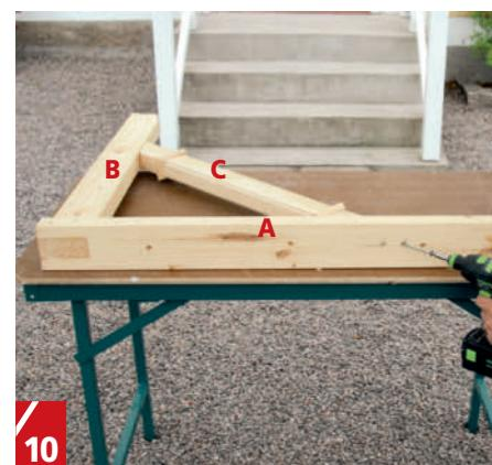
**Bor opp til avstiveren** bak på delen som skal sitte på veggen. Bor i sammenføyningen skratt bakfra. Lim og skru fast avstiveren med to 6 x 90 mm skruer. Til den øverste sammenføyningen skal du bruke lim og en 6 x 120 mm skrue.
