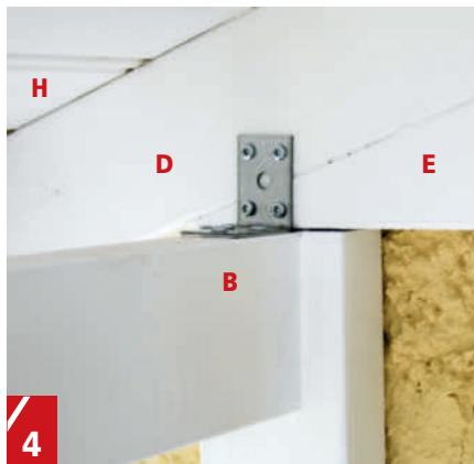
**4 Begge taksperrene festes til knektene** med vinkelbeslag, 35 x 50 x 50, fire i alt. De bakerste taksperrene skal dessuten skrus Wfast i veggene med franske skruer.
