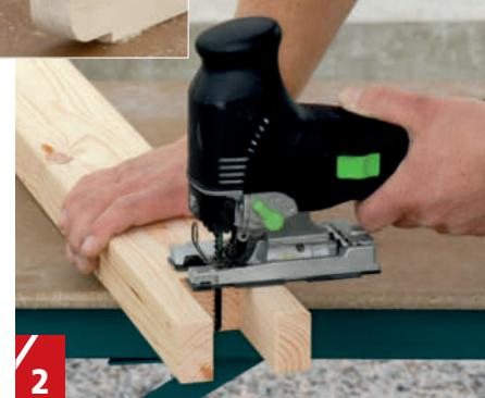
**Sag til fire lengder (48 x 98 mm)** – her 90 cm lange (A) og (B). De skal monteres to og to slik at du skal sage et hakk i midten av de to som skal sitte på veggen (A), og som overliggeren (B) skal hvile på.
