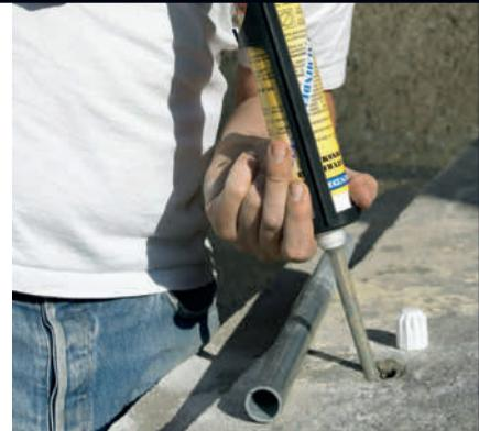
**3** Når du har renset hullet og sikret deg at røret kan gå ned til den riktige dybden, fyller du tokomponent klebemasse i hullet. Massen påføres kantene fra bunnen og opp til toppen.
