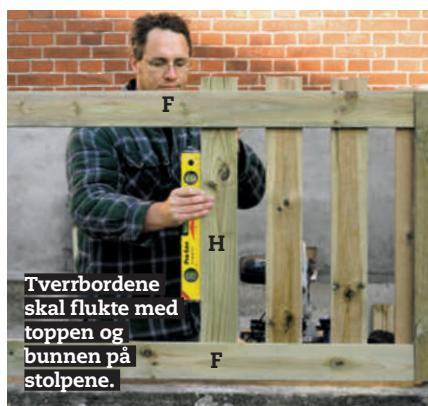
**7 Montér spildrene (H), og skru dem fast fra baksiden.** De skal sitte loddrett og flukte med underkanten av det nederste tverrbordet (F). Når de er på plass, skrur du på de to siste tverrbordene.
