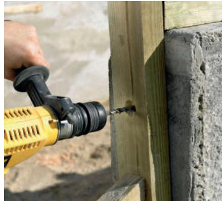
**3 Bor hull i muren gjennom stolpen** når den står der den skal. Hullene skal passe til klebeankrene som stolpen skal festes med.
