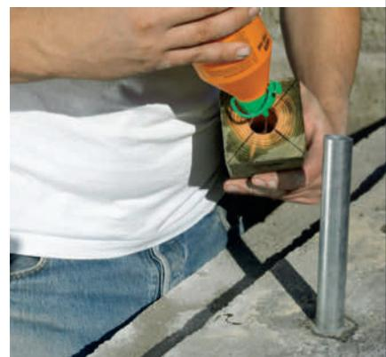
**8** Før stolpen settes ned over røret, legger du PU (polyuretan)-lim på kantene i hullet. Sett stolpen på plass, og vri den slik at den står riktig. Når limet er herdet, kan resten av gjerdet monteres.
