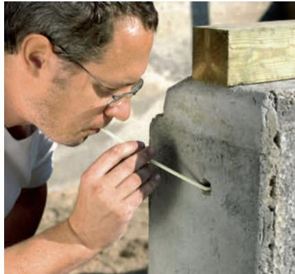
**4 Fjern stolpen, og rens hullene.** Du kan bruke et sugerør med knekk til å blåse rundt hjørnet. På den måten unngår du betongstøv i øyne og ansikt.
