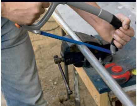
**1** Del opp det galvaniserte røret i lengder á 42 cm. Da kan røret gå 20 cm ned i betongen og 20 cm opp i stolpen, samtidig som det fortsatt vil være et par centimeter luft mellom stolpen og betongen.
