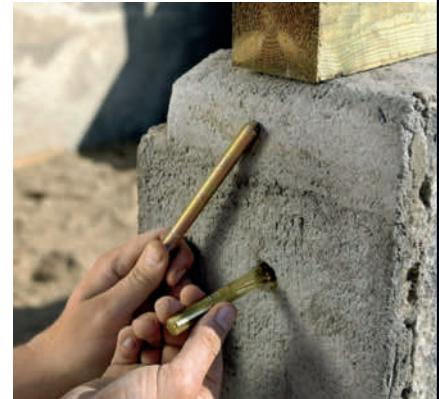
**5 Stikk ampullene til klebeankrene inn i hullet med den runde enden først.** Er ikke muren i lodd, kan du sette en ring av et vannrør på skruen for å utligne skjevheten.
