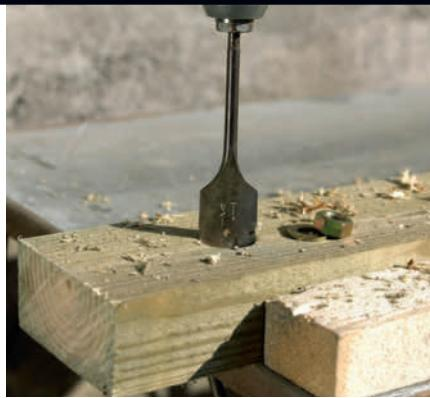
**1 Bor to hull i stolpene (A) til feste i betongmuren.** Begynn med en forsenkning til skruehodet eller mutteren, og bør helt igjennom med boret som passer til skruen.
