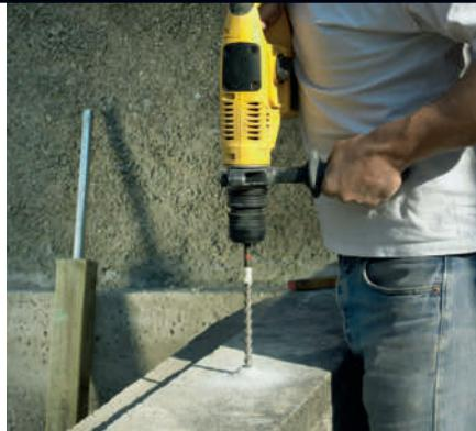
**2** Merk opp på muren hvor stolpene skal stå, og bor hull til det første røret. Bor i flere omganger. Med et merke på boret sikrer du at hullet blir nøyaktig 20 cm dypt. Ellers må hullet heller være litt for stort enn for lite.
