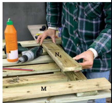
**8 Skru og lim fast de siste tverrbordene (N<sub>4</sub>, N<sub>5</sub>, N<sub>6</sub>), og sag til slutt av de loddrette bordene (M) slik at de flukter med overkanten av toppbordet (P).** Nå er porten klar til å få beslag.
