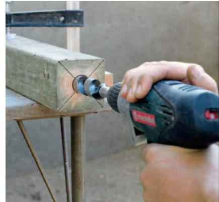
**6** Merk opp midten i bunnen av stolpen, og bor et 20 cm dypt hull med et spiralbor som passer til diameteren på røret. Det er viktig at hullet er vinkelrett på enden av stolpen.
