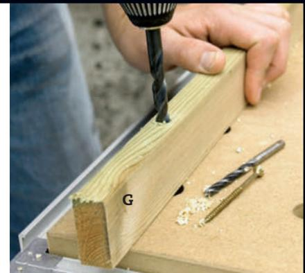
**2 Bor opp i monteringslistene (G).** Bor tre monteringshull, og forsenk hullet med et større bor slik at skruhodet kommer ned midt i lista.
