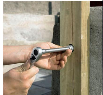
**7 Etter kort tid, avhengig av temperaturen, sitter ankret fast.** Heng stolpen på plass, og spenn fast med skive og mutter. Stolpene (C) festes også til husets grunnmur med klebeanker.
