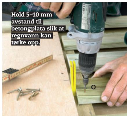
**6 Nå skal du skru de loddrette bordene (O) fast til det midterste tverrbordet (N<sub>2</sub>).** I toppen skrur du dem fast til det øverste tverrbordet (N<sub>1</sub>) slik at de ligger halvt opp på tverrbordet.
