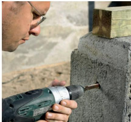
**6 Drei det gjengede stykket av ankeret inn i hullet med drillen.** Da knuses glassampullen, og limet blandes.
