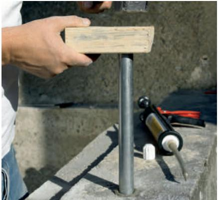
**4** Sett røret i hullet, og press og vri til røret er helt i bunnen. Er hullet trangt, kan det være nødvendig å slå røret det siste stykket. Bruk en hammer og en kloss slik at det ikke deformeres.
