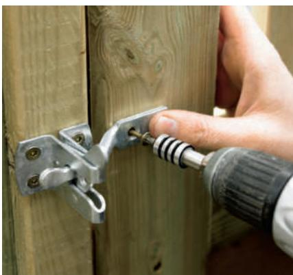
**3** På den motsatte siden monterer du en grindlås. Gjerdet er så åpent at du kan stikke hånden gjennom det og åpne porten utenfra.
