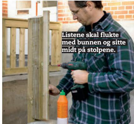
**4 Fest monteringslistene med PU-lim (polyuretan),** og skru dem fast på siden av stolpene. Legg merke til at lista stikker opp over stolpen.
