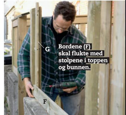
**5 Sag til fire vannrette bord (F)** som skal passe nøyaktig til avstanden mellom stolpene. De to første monteres på yttersiden. Skru fra baksiden gjennom monteringslista (G).
