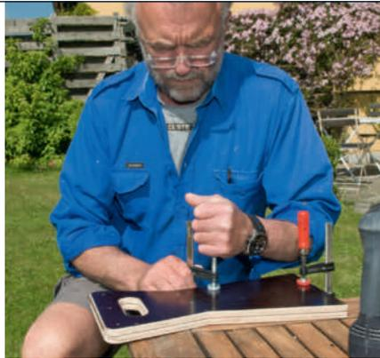
**1** Spenn sammen sidene (D), og bor hull der de skal skrues sammen med sete, bakstykke og hyll. Bor først helt gjennom med et 3 mm bor. Deretter forsinker du, slik at hodet på skruene akkurat vil bli trukket ned i nivå med den harde overflaten.
