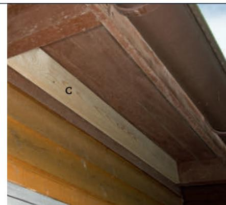
**2** **Mellom sperrene setter vi bord (C)** som flukter med undersiden av sperrene. Da kan de nye kledningsbordene (A) legges opp mot dem.
