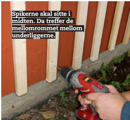
**3** Det er smart å for bore i topp og bunn av listene. Det gjør at de ikke sprekker når de spikres så langt ut i kanten. Et 4 mm trebor passer fint til spikerne våre, som er 3,4 x 100 mm.
