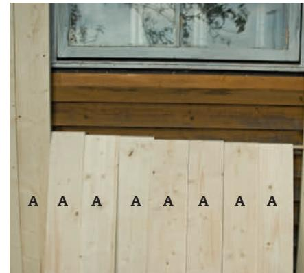
**5** **Avstanden mellom bordene:** Her er det plass til sju bord. Når de står helt tett, er det ca 5 cm luft. 5 cm delt på åtte mellomrom, er 0,62 cm. Det er den avstanden det skal være mellom bordene.
