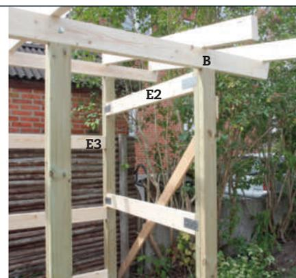
**2** Overkanten av den øverste tverrstiveren (E2) i gavlen flukter med underkanten av svillen (B) i fronten. Tverrstiverne (E3) på bakveggen settes fast med vinkelbeslag fra baksiden.
