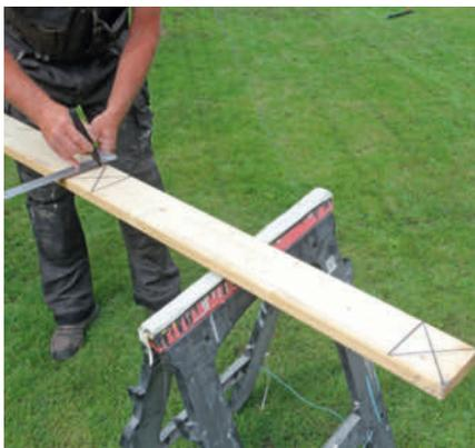
**4 Tegn opp plasseringen til alle de fire frontstolpene** på to rette bord, et til bunnen og et til toppen. Lag to bord til de tre stolpene i bakveggen også.
