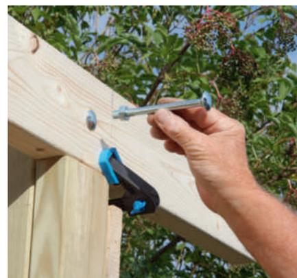
**5** Stikk inn en 12 x 120 mm bolt i hullene. Bank inn bolten med en hammer. Sett på spennskive og mutter på den andre siden, og skru fast.
