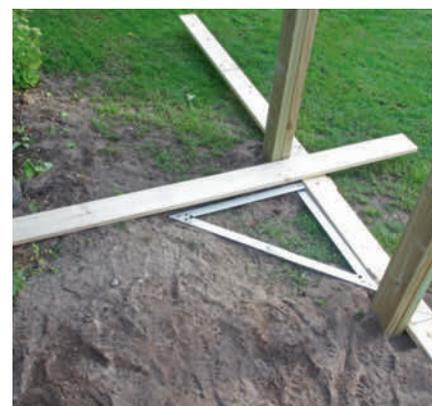
**8 Marker dybden til huset (150 cm) på et bord,** og legg det vinkelrett på det fremste plasseringsbordet. Bor hull i bakken på begge sider etter de bakerste plasseringsbordene, og sett opp stolpene.
