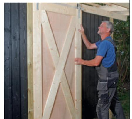
**8** Sjekk at skyvedøren kjører som den skal, og at stopperne sitter der de skal. Ta av døren, og gi den grå trebeskyttelse. Det som enda ikke er malt, får svart trebeskyttelse nå.
