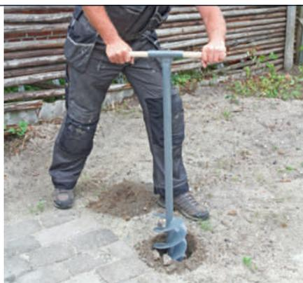
**3** Begynn på det første hullet med jordboret. Det bores ned med håndkraft. Hvis bakken er tilstrekkelig myk, går det fort å lage et hull. Møter du på steiner, bytter du redskap.
