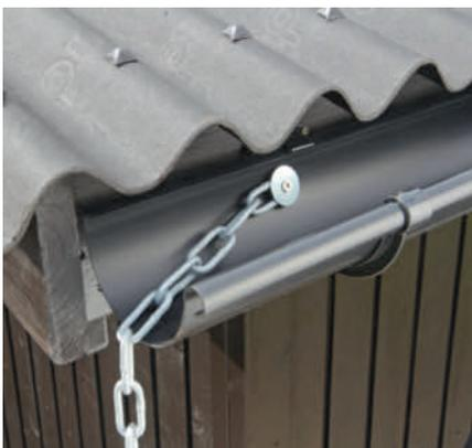
**3** Monter takrennen med et fall på 1 cm. Steng takrennen i den ene enden, og skru fast en kjetting i den andre enden, der vannet skal renne ut.
