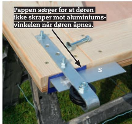
**4** Monter de to rullebeslagene i toppen av døren. Høyden finner du ved å legge en bit av aluminiumsvinkelen (S) og et stykke 1 mm papp som vist på bildet, mens du skrur fast rullebeslaget med to 8 x 60 mm bolter og to skruer.
