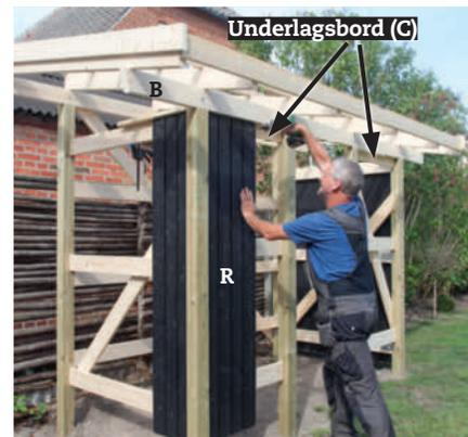
**5** Skru på kledningsbordene (R) med 5 x 60 mm skruer. I fronten skrues de fast øverst til underlagsbord (C), som er satt fast til toppsvillen (B).
