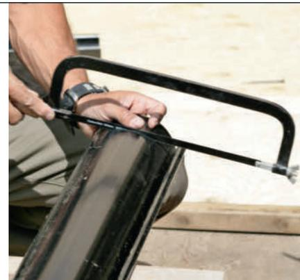
**2 Kapp takrennen** med en baufil. Du skal ikke bruke vinkelsliper på alusinkrenner, fordi varmen den skaper ødelegger rennen. Det er heller ikke nødvendig – rennen er lett å sage i.
