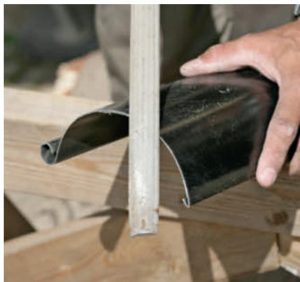
**3 Fil de skarpe kantene (gradene) glatte,** da de kan skape utette skjøter. De fjernes raskt med et par strøk med en fintannet fil. Pass på ikke å skade overflaten.
