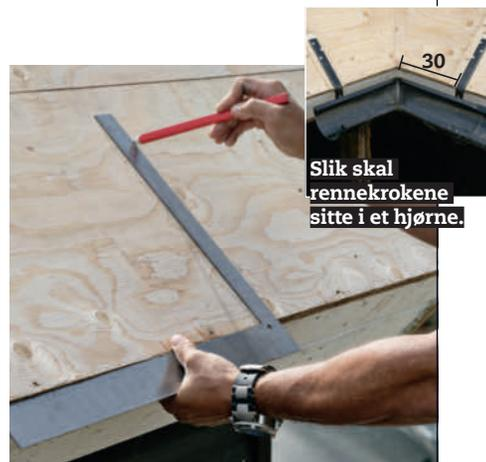
**4 Merk opp på taket** hvor krokene skal være. En avstand på 60 cm er maksimum. Hvis du har et innvendig hjørne, så begynn merkingen der, slik at hjørnerennen blir understøttet riktig.
