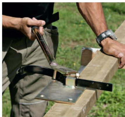
**3** Bøy den første rennekroken. Skru fast rennekroksknekkeren på et bord, og prøv deg fram til du finner vinkelen. Forkant av rennen skal ligge 1-2 mm under bakkanten, slik at evt. overskuddsvann ikke renner baklengs ned på husveggen.
