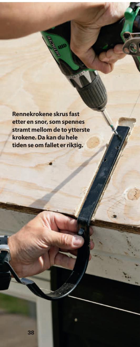
Rennekrokene skrues fast etter en snor, som spennes stramt mellom de to ytterste krokene. Da kan du hele tiden se om fallet er riktig.
