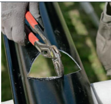
**3** Bøy ned kanten med en tang, slik at vannet fritt kan renne ned i nedløpet. Det er nok å bøye de ytterste par millimeterne med en vannpumpetang.
