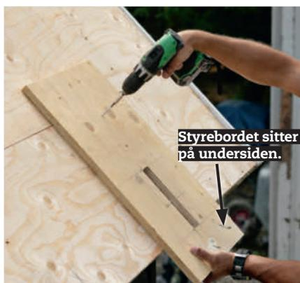
**5 Dytt malen opp til takkanten,** og la den flukte med oppmerkingsstreken i siden. Skru fast malen med et par skruer, slik at den ikke glipper mens du freser.
