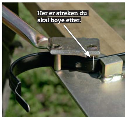
**4** Bøy alle rennekrokene etter strekene. Legg dem tilbake i den rekkefølgen de skal brukes. Merk deg at jo kortere den rette delen av kroken er, desto større vil fallet på takrennen være.
