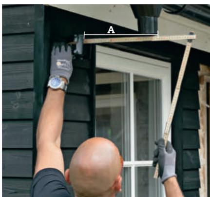
**8** Hold opp en rørbæring, og mål avstanden (A) til nedløpsstussen, slik at du kan tilpasse en bøy som skal gå ned i det loddrette nedløpsrøret.
