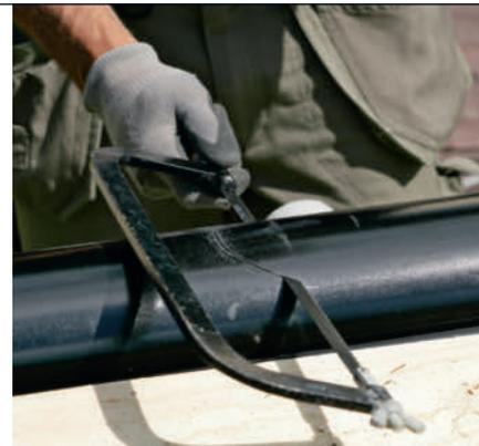
**2** Sag ut hullet til nedløpet i takrennen med to skrå snitt med ei baufil. Fil kanten glatt, slik at det ikke blir noen skarpe grader.
