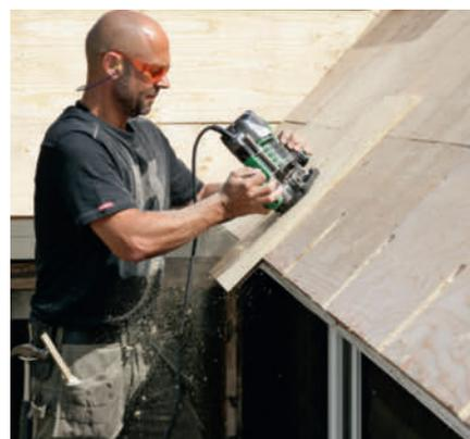
**6 Fres ut til rennekrokene etter strekene.** I forkant skal du ha justert frese dybden, slik at den tilsvarer tykkelsen på rennekrokene. Det vil være 4-6 mm, avhengig av dimensjonen på takrennen.
