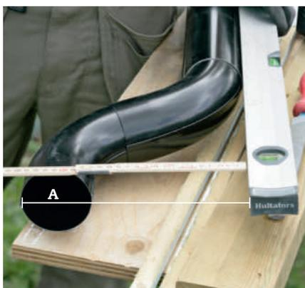
**9** Sett sammen bøyen, og sett den fast i nedløpsrøret. Hold et vater på nedløpsrøret, slik at du kan sjekke at avstanden (A) passer fra hullet i bøyen og til dit rørbæringen skal sitte på røret.
