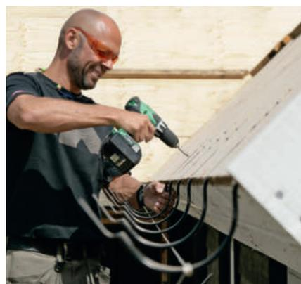
**6** Skru fast alle rennekrokene i sporene. Begynn med de ytterste, og spenn ut en snor mellom dem. Da har du en ekstra kontroll når du setter fast de mellomliggende rennekrokene.
