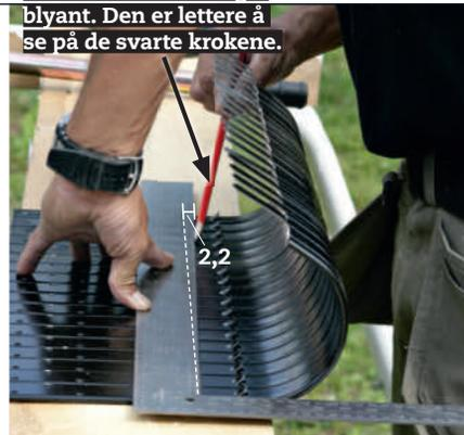
**2** Tegn inn fallet på rennekrokene. Fallet skal her være 1,5 mm per meter, dvs. 16,5 mm på 11 m tak. Tegn opp etter en vinkel eller en linjal. Skriv nummer på krokene, så du har kontroll på rekkefølgen.
