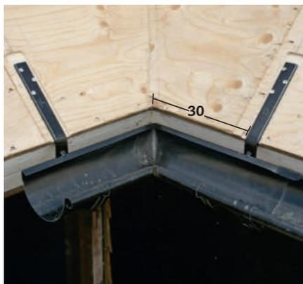
**5 Monter hjørnet først,** hvis du har et hjørne, og beveg deg ut mot endene. Merk deg at hjørneelementet bæres av to rennekroker som sitter ganske tett.
