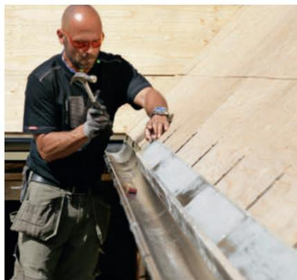
**6 Slå på beslag** når takrennene er på plass. Takfotbeslaget spikres på. Det er utstyrt med en asfaltstripe, slik at takbelegget har noe å hefte fast til.
