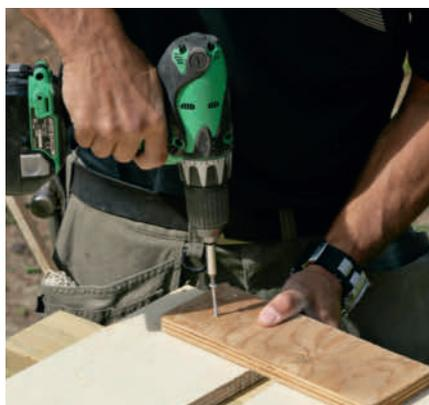
**3 Skru et (10 cm) bredt styrebord** på baksiden. Sørg for at bordet ligger helt vinkelrett på hullet i malen. Dermed har du et fast anlegg, som skal dyttes helt inntil kanten av undertaket før du freser.
