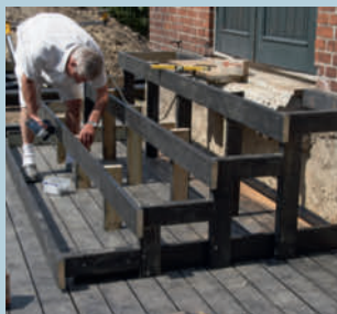
Øverst settes det fast en svill på veggen. Ut fra den bygger tømmeren resten av skjelettet.
