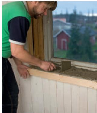
**4** Fordel betongen, og hakk i den med murskjeen for å få ut all luft av den. Slå også på forkanten med en hammer, slik at du får ut luftboblene.
