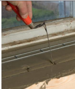
**5** Legg ned et par armeringsjern for å styrke platen. Da unngår du at den sprekker fordi veggene gir seg litt. Trykk ned armeringen i midten av betonglaget.
