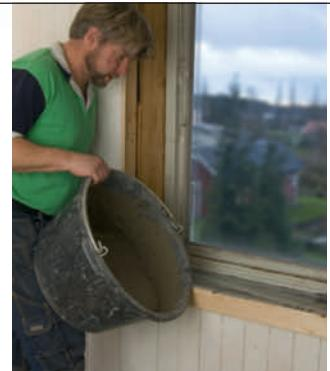
**3** Fyll opp med betong. Kjøp en ferdig støpeblanding, og regn med at det blir ca 17 liter av en 25 kilos sek. Høyde x bredde x dybde i cm, dividert med 1000. Da har du antall liter du skal bruke.
