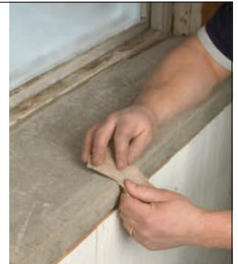
**7** Slip kantene med slipepapir når betongen er tørr og forkanten er fjernet. Avslutt eventuelt med å gi platen en overflatebehandling, f.eks. lakk eller silikonolje.
