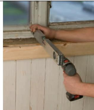
**2** Monter en forkant eller en støpeform med utstikk. Overkanten skal flukte med overkanten av den ferdige betongplaten. Formen fores med en kraftig plastfolie.
