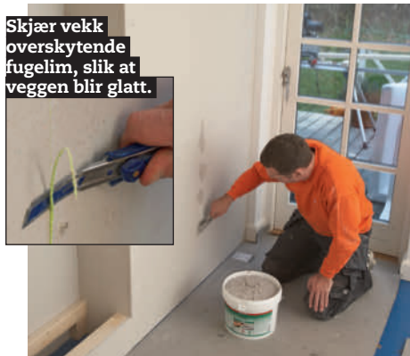
Fyll sparkelmasse på sparkelen, og trekk den på veggene – nedenfra og oppover.
