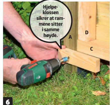
**6** **Når begge sidene er på plass**, skal gavlen skrus på plass mellom dem. Skru en hjelpe-kloss på hver av de to bakerste stolpene (A), i flukt med underkanten på rammene. Bruk 5 x 80 mm skruer.
