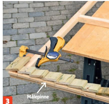
**Gjør en prøveopplegging** av noen kledningsstumper for å finne plasseringen på bordene (F). Overlappen skal være minst én centimeter. Marker plasseringen på en list, og bruk den som målepinne.
