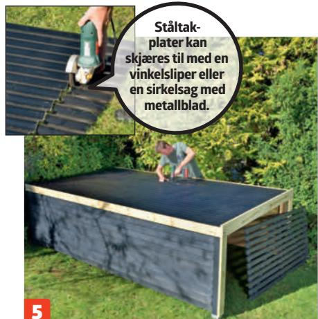
**Legg de to takplatene** på plass oppå sperrene mellom kantbordene. Skru fast platene til sperrene med takskruer.
