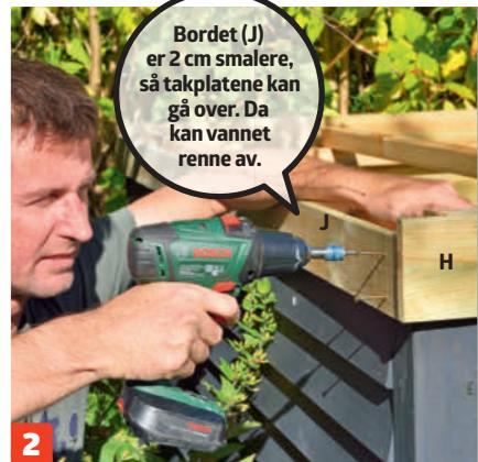
**Skru fast kantbordene (H).** De skal stikke 2 cm over sperrene for å flukte med takplatene. Det bakerste kantbordet (J) skal lages 2 cm smalere.
