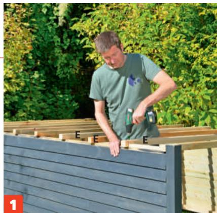
**Mål ut hvor de ni sperrene (E) skal skrus på,** og skru dem fast med 5 x 80 mm skruer. Kapp eventuelt til en lektestump, og bruk den som mal mellom sperrene.
