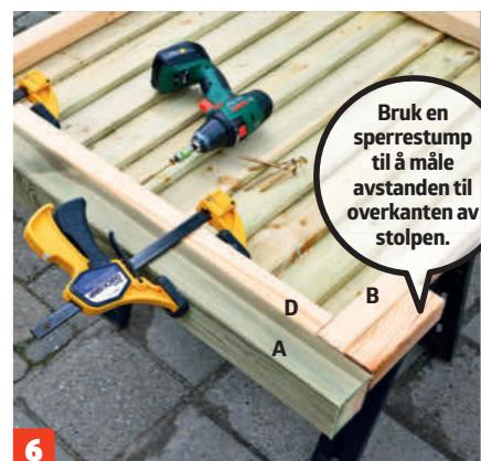
**Skru fast de fire hjørnestolpene (A)** til hver ende av de to sidene med 6 x 100 mm skruer. Stolpene plasseres slik at toppen kommer til å flukte overkanten av sperrene. Gavlen bygges etter de samme prinsippene.
