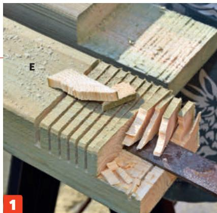
**Sag spor i stolper (E) og sperre (B), og stem ut** så du kan lage bladskjøtene. Juster kapp-/gjærsagen så den sager halvveis ned i treet i endene, og lag en rekke snitt. Fjern treet med et skarpt stemjern.
