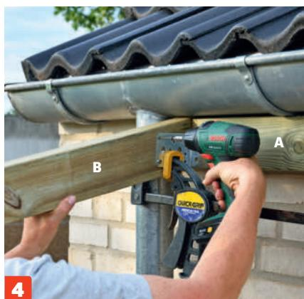
**Skru fast sperrene (B) til svilien (A)** med 70 x 70 x 70 mm vinkelbeslag og 4 x 35 mm skruer. Når vinkelbeslagene er satt fast, kan stolper og sperre reises og skrus fast. Hold sperrene med tvinger mens du skrur.
