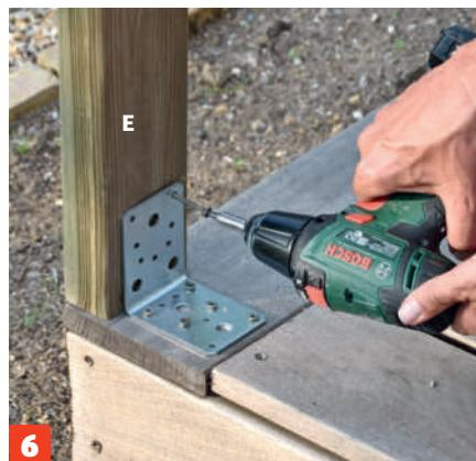
**Stolpene (E) skrus fast til vinkelbeslagene** med 4 x 35 mm skruer. Alle vinkelbeslag er først montert til terrassen. Det er derfor enkelt å skru fast stolpen etter at du har sjekket at den står helt rett.
