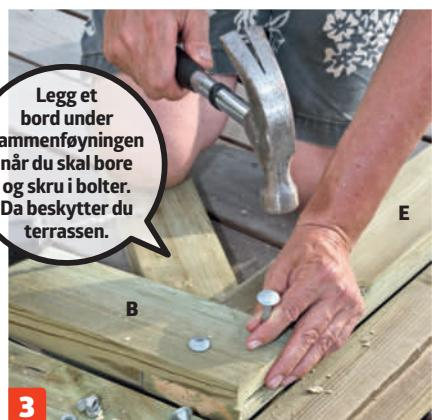
**Stolper (E) og sperre (B) skrus sammen** med to 10 x 60 mm bolter. Hold først stolpe og sperre sammen i skjøten, og bor hull med et 11 mm bor. Slå i boltene, sett på en stoppskive og spenn dem sammen.
