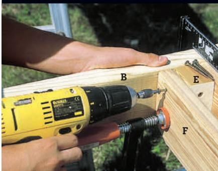
**1** To terrassebord (F) tilpasses slik at de er 55–60 cm kortere enn bordplata. Sag dem skrått av nede slik at endene får samme høyde som overliggeren (B). Skru dem fast til klossene (E) slik at de flukter med overkanten på bukken.
