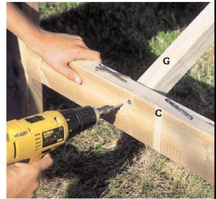
**6** Nede på bukken monterer du skråavstiveren (G) med to skruer gjennom tverrvstiveren (C).
