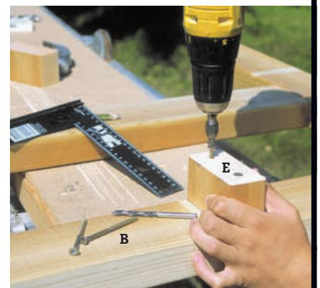
**5 Midt på de to overliggerne skrur du fast en 8 til 10 cm stor kloss (E) med samme tykkelse.** Bor to hull i klossen, og monter den med litt PU-lim og et par lange skruer.
