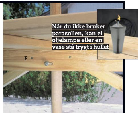
**2** Under bordet kan du feste parasollen ved å bore et hull gjennom bordene (F) og parasollstanga og sette en låseskrue gjennom hullet.
