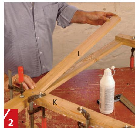
**Tilpass listene L** slik at de går nøyaktig mot listene K. Bruk rikelig PU-lim, og sett listene i press med tvinger med ca. 25 cm avstand. Gjør det samme med listene M og P. La limet tørke i minimum en time. Fjern så overflødig lim med slipepapir og eksentersliper.
