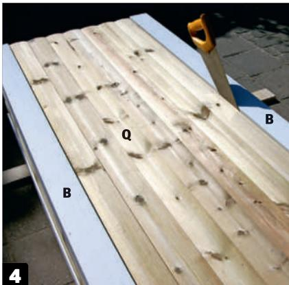
**4** **Sag løs døren** når alle kledningsbordene (Q) er satt fast. Det gjøres med en håndsag, som stikkes ned mellom døren og stolpene, (B) slik at du kan sage av spikerslagene (E).
