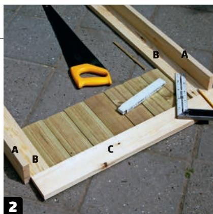
**Mål opp til spikerslagene (C), og kapp dem til.** Det er smart å gjøre en prøveopp-lenging med deler av kledningsbordene (Q), som legges mellom hjørnestolpene. Fjern en eventuell fjær av det ytterste bordet.
