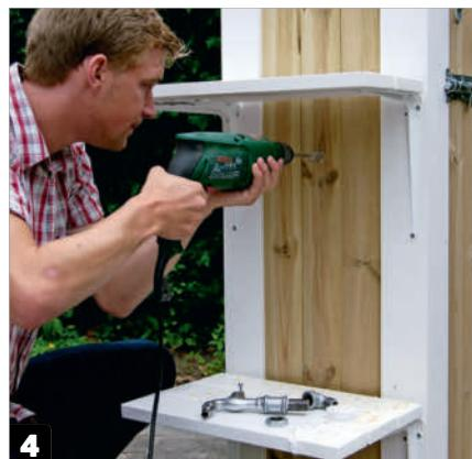
**Bor hull i vegg** til en vannkran, hvis du vil ha rennende vann lett tilgjengelig. Vi bruker et 19 mm borer og lager hullet midt på veggjen, 78 cm fra bunnen.
