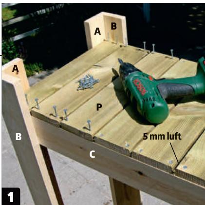
**1** **Bunnbordene (P)** skrus fast til spikerslagene (C) nedenfra. Du må snu skjelettet rundt for å komme til. Bordene monteres med en avstand på 5 mm med 4 x 50 mm skruer.
