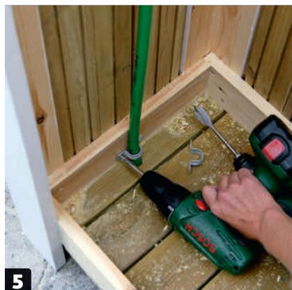
**Bor også hull i gulvet**, slik at en hageslang kan føres inn. Skru også fast et U-beslag rundt hageslangen, så den blir holdt på plass langs veggjen på bunnen.
