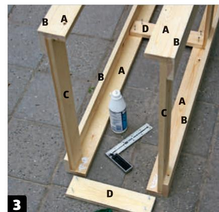
**De lange (C) og korte (D) spikerslagene** **skrus fast** med 4 x 40 mm skruer, i tillegg til at de limes. De korte spikerslagene (D) måler du opp og sager til etter samme prinsipp som de lange.
