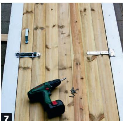
**7** **Monter døren.** Den legges på plass i hullet, og hengsler, dørgrep og skåte skrus fast med de tilhørende skruene.
