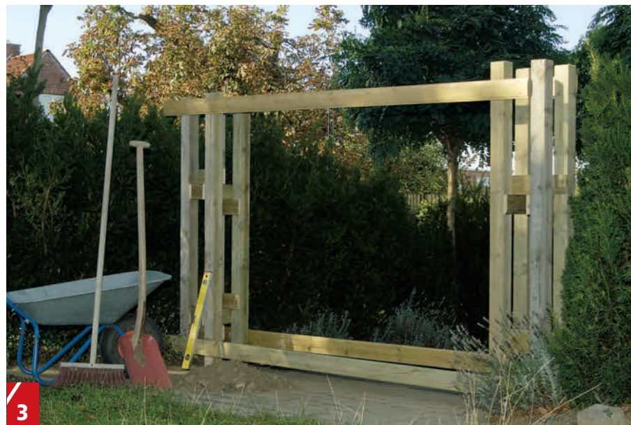
3 Pass på at søylene flukter med hverandre , eventuelt ved å feste noen lange bord på siden av søylene som her. Tøm litt vann ned på tørrbetongen. Fyll opp med jord som stemples godt til.
