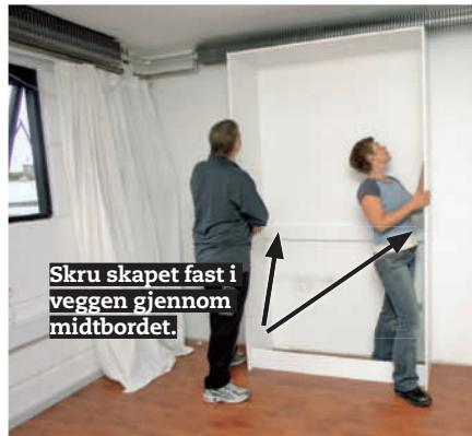
**4** Sett skapet på plass. Kontrollér med et vater at skapet står loddrett. Markér plasseringen på veggen slik at du kan sette plugger i veggen – avhengig av hva veggen er laget av.
