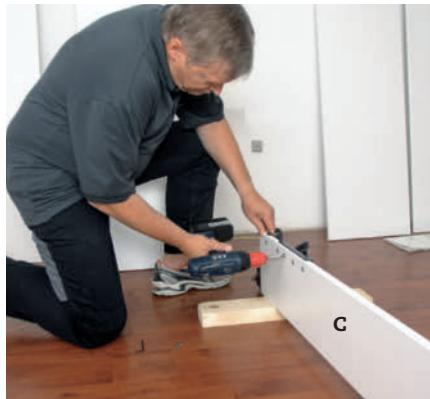
**4 Skru fast dreiebeslaget til ramma** innvendig. Vent med de tre skruene i forsiden av beslaget.
