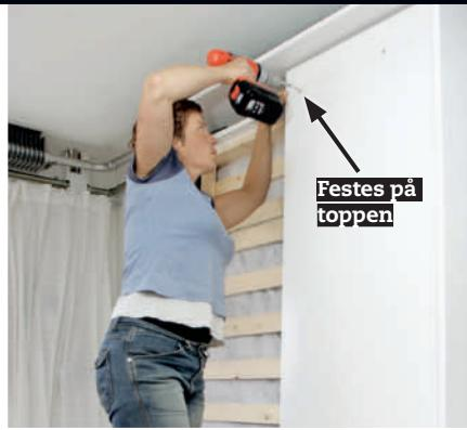
**2** Skru fast mdf-platene på toppen, bunnen og sidene med treskruer, 5,0 x 60 mm. Bor opp og forsenk skruene. Lengen på platene er tilpasset slik at de går fri av fotspennet når senga vippes opp og ned.
