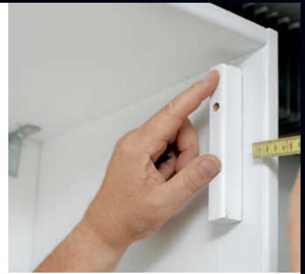
**3** Sett en stoppkloss øverst i skapet. Den lille mdf-klossen setter du 20 mm fra framkanten. Stoppklossen gjør at sengebunnen flukter med skapsidene når den står loddrett.
