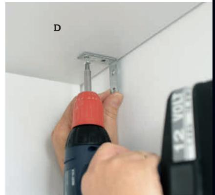
**5** Skru fast topplata (D) til veggen med to vinkelbeslag innvendig i skapet eller oppå topplata. Bruk skruer etter hvilken veggtype du har.
