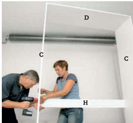
**3** Reis opp skapet, og skru deretter fast midtbordet (H) cirka en meter over gulvet. Bor opp, og monter med møbelmonteringsskruer M 6,3 x 80 mm.
