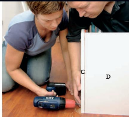
**1** Montér skapsidene med lange møbelmonteringsskruer M 6,3 x 80 mm. Du bør bore opp med et 5 mm bor slik at platene ikke sprekker. Møbelkruene strammes etter med en unbrakonøkkel.
