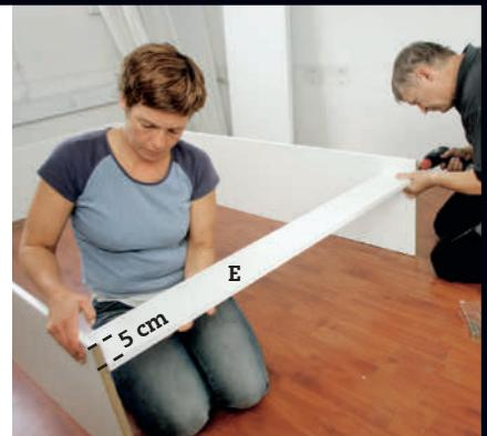
**2** Skru fast skapfronten (E) slik at den er trukket 5 cm tilbake fra framkanten. Bor opp med et 5 mm bor, og monter med møbelmonteringsskruer M 6,3 x 80 mm. Sett to skruer på hver side.
