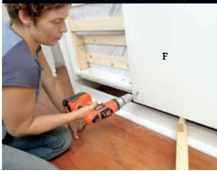
**1** Skapfronten (F) monteres på sengebunnen. Vi har valgt 19 mm tykke mdf-plater sagd på mål etter den innvendige bredden på skapet. Beregn cirka 8 mm luft langs skapsidene.
