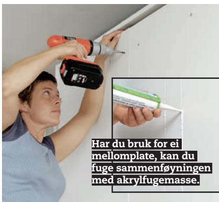
Har du bruk for ei mellomplate, kan du fuge sammenføyningen med akrylfugemasse.
