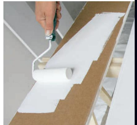
**4 Mal alle platene.** Først et strøk grunningsmaling (akryl), så en mellomsliping med slipepapir korn 180 og endelig to strøk maling. Rull på malinga med en skumrull slik at det blir ei pen overflate på alle platene.
