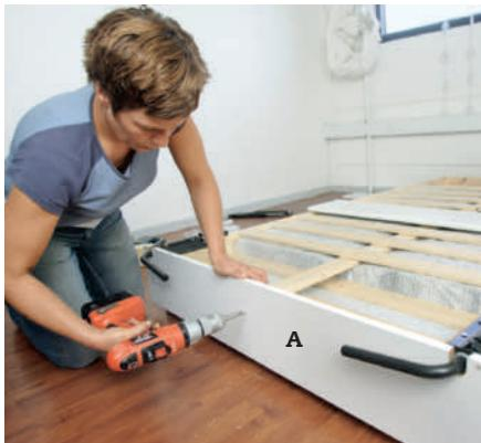
**4** Bor gjennom de korte sidene (A) og bunnramma ut for markeringene dine med et 4,5 mm bor. Skru fast plata med 5,0 x 60 mm treskruer.
