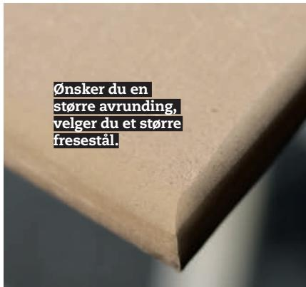
**3 De rundede kantene** er behagelige å ta på, pene å se på og langt lettere å male pent enn skarpe kanter. Tørk støv av platene før du maler dem.
