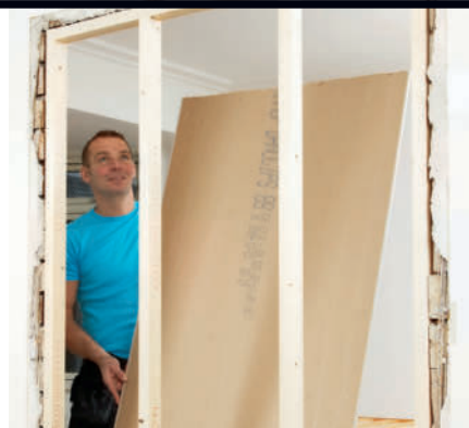
Skjær med en skarp hobbykniv etter et vater, brekk av gipsplaten og skjær den helt løs.
