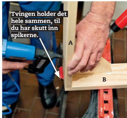
**3 Sett de fire trekantene (C) fast i rammens hjørner.** Spenn dem fast med tvinger. Trekantene sikrer at rammen dermed er helt i vinkel.
