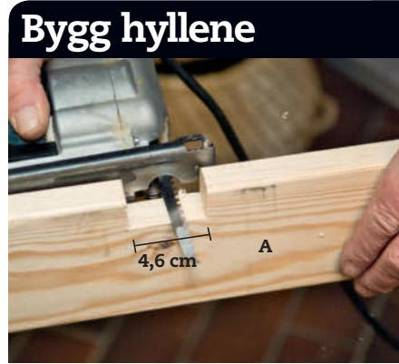
**1 Sag ut et hakk der du markerte på de to langsidene (A).** Hakket skal være 4,6 cm bredt – 2,3 cm på hver side av markeringen. Sag loddrett ned med stikk-sagen, deretter skrått. Fjern det siste med et vannrett snitt. Legg i tverrstiveren (K).
