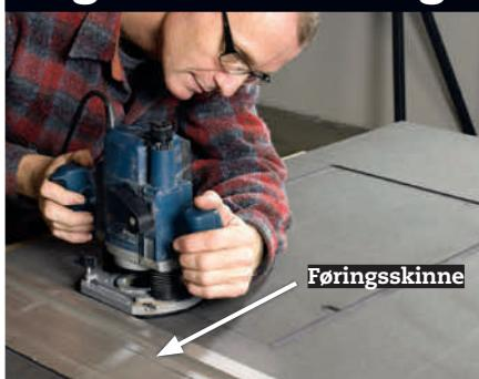
**1** **Markér først hvor underlaget skal være.** Justér deretter overfresen til en dybde som passer til linoleumen, normalt 3 mm. Fres så kanten rundt ved hjelp av en overfres og ei føringsskinne.
