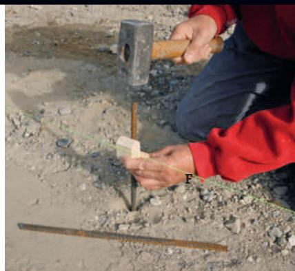
**1 Spenn ut en snor for å markere hellekanten i den ene siden.** Bank pluggar av kamstål (F) ned i bakken. Hold en bit av et forskalingsbord (C) mot snoren for å sikre samme avstand hele veien. Pass på å unngå en buet forskaling.
