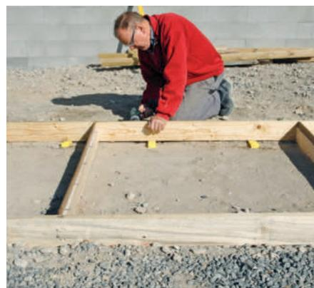
**4 Bordet ved snoren heves med kiler opp til snoren.** Klipp stykker av hullbånd (K), og fest bordet til pluggene med hjelp av hullbånd og skruer.
