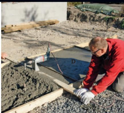
**1 Legg grovbetongen (D) i formen med et par cm overhøyde, og trekk bjelkevibratoren (se boks under) over formen, slik at du får "grovjevnet" overflaten. Stopp vibratoren jevnlig, og skrap betongen av oversiden.**
