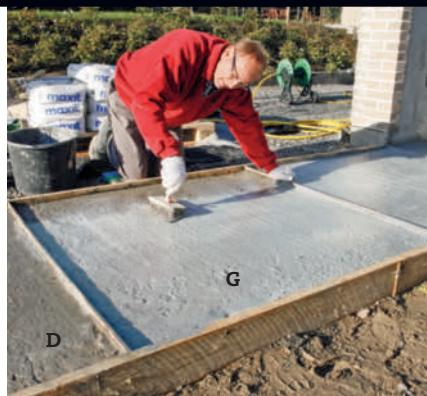
**2 For å sikre god vedhefting av slitelaget slammes overflaten.**
