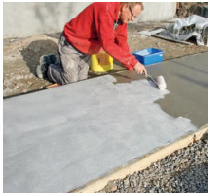
**5 Når overflaten er fast, rulles et jevnt lag overflateretarder på.**
