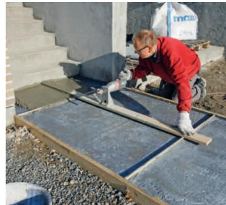
**3 Mens slammelaget fortsatt er vått, lesses betongen til slitelaget (H) i formen.** Fyll på til en halv helle om gangen – med cirka 1 cm overhøyde.
