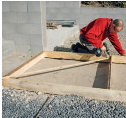
**3 Finn en list som kan rekke diagonalt over hellen.** Skru den fast i to motstående hjørner, slik at formen fikseres i helt rett vinkel.
