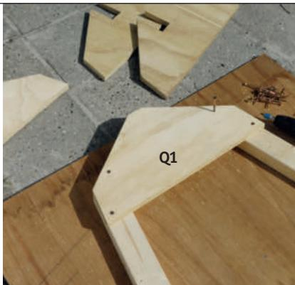
**4 Skru den første gavlplaten (Q1)** på stolpene med 5 x 50 mm skruer. Gi eventuelt skjøtene en stripe trelim før du skrur på platen. Avslutt med å skjære stolpene skrått av nederst, slik at høyden blir 200 cm fra topp til bunn.
