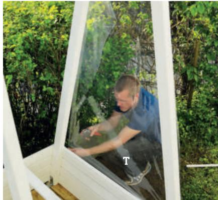
**3 Gavlene kles.** Start med å feste folien (T) øverst. Deretter nederst, og til slutt i sidene. Når gavlene er kledd, skrur du fast bordene (H) med 4 x 40 mm skruer.
