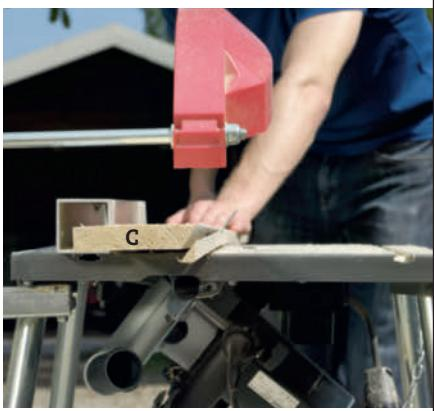
**3 Skråskjær to av kledningsbordene** (C) langs overkanten, slik at de flukter med gavlplatene (Q1) og (Q2). Har du ikke en bordssirkelsag, kan du bruke en vanlig sirkelsag med sideanlegg.
