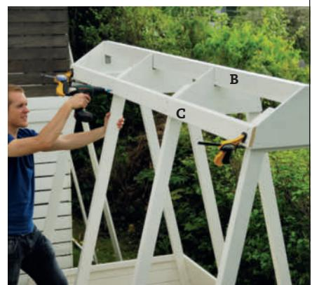
**6** Skru på de to øverste kledningsbordene (C). Et på hver side av drivhuset. Også her er det smart å holde bordene med tvinger før du skrur dem fast med to skruer i hver gavl.
