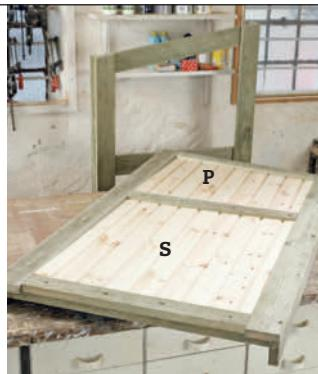
**2 Skjelett og kledning** skal ha hver sin farge. Derfor er kledningsbordene bare lagt løst ned i feltene. De grunnes og males med trebeskyttelse før de festes permanent til sidene.
