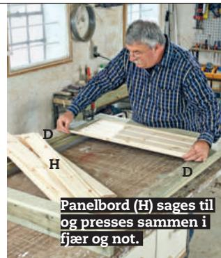
**2** Bordene (D) skrus fast på (B) med 5 x 45 mm skruer, slik at du får en 25 mm dyp fals i bunn og topp på losholte. De ytterste panelbordene (H) sages til i bredden. Etter tilpassing fjernes de igjen, og males.
