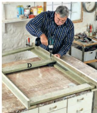
**2** Neste losholt (D) plasseres slik at det er 100 cm fra losholtens overkant til undersiden av hjørnestolpen. Skru den fast med 5 x 45 mm skruer. Merk at midterste losholt er 125 mm bred.
