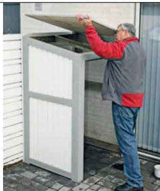
**2 Finéplaten (Q) legges på plass og festes til de underliggende bordene med 5 x 45 mm skruer. Legg merke til at kanten på platen er både grunnet og malt.**
