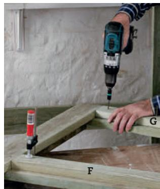
**4** Snu siden, og tilpass 25 x 75 mm bord (F og G), slik at de passer stramt mellom hjørnestolpene. De festes til losholtene slik at du får en fals.
