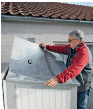
**5 Sinkplaten (G) presses ned i montasjelimet.** Senere legges en dekklist på skilleveggen. Den skal lukke sprekken mellom vegg og tak.
