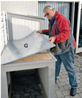
**3 Stripene av montasjelim legges langs kanter og per 25 cm inne på finerplaten. Deretter planes de ut med en fintannet tannsparkel. Sinkplaten (G) legges på og presses ned i limet.**
