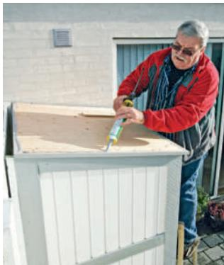
**3 Sinkplaten skal limes fast** med montasjelim. Bruk en fugepistol og press stripene av lim ut på finerplatén.
