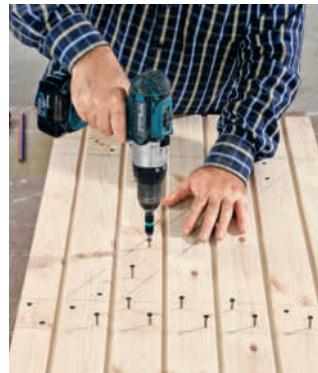
**4 Panelbordene er for tynne til** at skruene kan holde hvis de skrus inn gjennom labankene fra baksiden. Derfor må vi leve med synlige skruhoder på forsiden.
