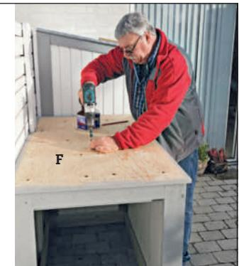
**2 Finerplaten (F) skrus fast til de underliggende bordene. Platen skal stikke 2 cm ut i forkant og venstre side. Merk at platens kanter er lukket med flere lag maling.**
