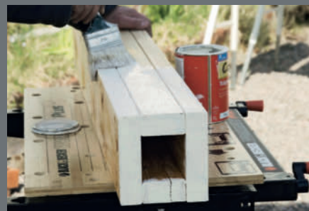
Stolpene grunnes med et tykt lag oljebasert grunning, og males.
