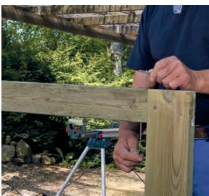
**4** Når du har boret og stemt ut i begge sider av rammen, trekkes wiren gjennom hullet og festes rundt spikeren. Senk spikeren helt ned i falsen.
