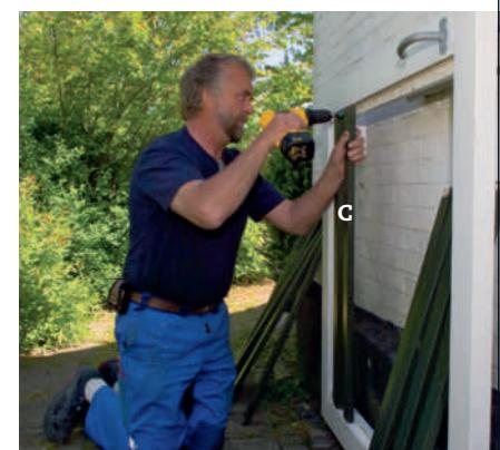
**6** De loddrette stavene (C) sages på mål, og i en vinkel på 7 grader i topp og bunn. De grunnes og males før de monteres med minst 7 mm glippe til den nederste bjelken. Avstanden mellom stavene fordeles jevnt.
