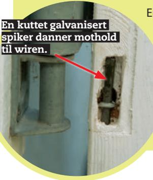
En wire monteres slik at den går fra øverste hjørne i hengselsiden og skratt ned. Det er stikk motsatt av en tradisjonell skråstiver av tre. Wiren henger fast i et mothold i hver ende. Motholdet plasseres i en not (se bilde). Noten bores og stemmes ut i bladskjøten.
