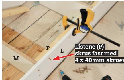
**3 På innsiden av sokkelen monteres fire støttelister (P).** De skal utelukkende sikre at det er solid treverk å skru fast kjøkkenelementene til.
