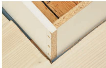
**2 Mellom sokkel og gulvbord skal det være 1 cm avstand.** Da kan det flytende gulvet bevege seg. Har du et fast gulv, kan kjøkkenøya bygges direkte oppå.
