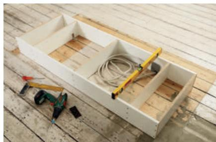
**1 Sokkelen bygger vi av en plate melamin.** Stykkene skrus sammen med 4x40 mm skruer, og festes til gulvet med små vinkelbeslag. Sørg for at sokkelen er i vater – da er det enklere å bygge videre.
