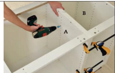
**1 Sett de tre skapene (A og B) på plass** på sokkelen, og skru dem sammen. Hvis det fulgte med sammenføyningsskruer, bruker du dem – ellers kan du bruke 4 x 35 mm skruer.
