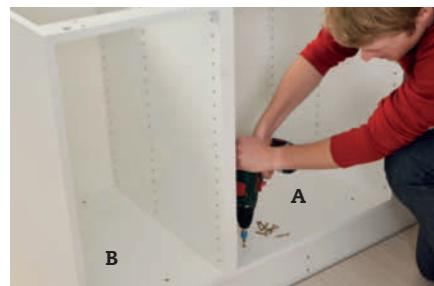
**2 Skru fast skapene (A og B) til sokkelen** med 4 x 40 mm skruer. De skrus gjennom bunnen til skapene ned i støttelistene (P).
