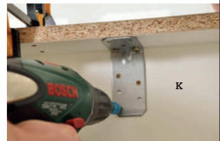
**3 Skru fast bakkledningen (K) til sokkelen** med 4 x 35 mm skruer. Øverst i skapet settes et par vinkelbeslag. De skrus gjennom bakveggen i skapet og inn i bakkledningen (K) som du har laget.
