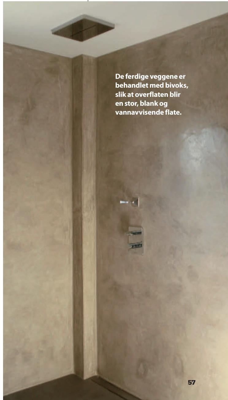
De ferdige veggene er behandlet med bivoks, slik at overflaten blir en stor, blank og vannavvisende flate.
