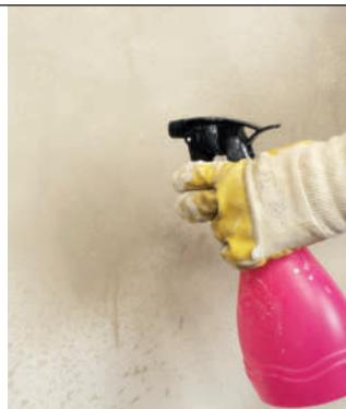
**1 Start med å sprøyte vann** på én kvadratmeter av den vegg du pusset dagen før. Vannet skal på for at fukten ikke skal trekkes ut av tadelakten når den påføres.
