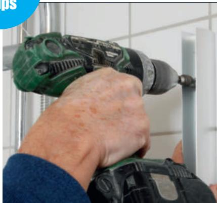
**3 Bank et gipsanker i veggen.** Først legges de to mothakene ned med en tang. Skruen skrus deretter så mye ut, at du kan få tak med tangen. Klem tangen til du merker at "beina" er spredd på baksiden.
