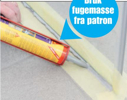
**1 Nå skal det fuges rundt kantene.** Legg teip på begge sider av sprekken, og påfør den grå fugemassen. Bruk en god fugepistol og fugepatron. Da er det enklest å styre fugemassen. Opp langs sidene av aluminiumslistene brukes en klar silikon.
