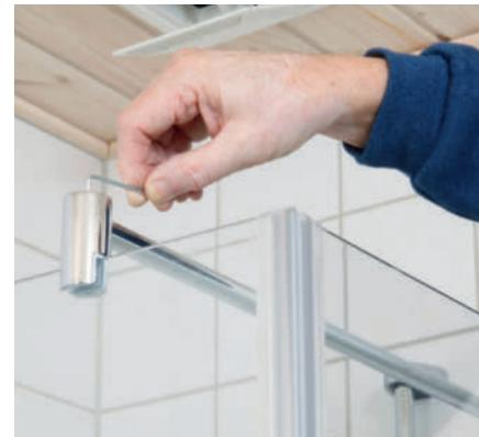
**1 Sett teip på vegggen når døren og sideveggen er i lodd.** Plasser teipen tett mot U-profilen øverst og nederst, ut for de forborede hullene i profilen. Ta ned sideveggen og døren og fjern profilene.
