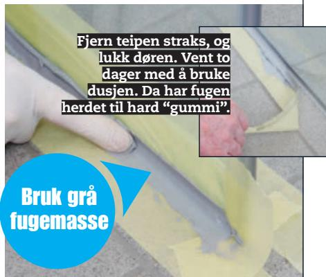
**2 Glatt fugen med en finger.** Bruk plasthansker, og press fugemassen godt inn. Du skal fuge på begge sider av glassveggen. Pass på ikke å dytte til den. Den grå fugen passer godt til dette gulvet. Glatt til de loddrette fugene på samme vis.
