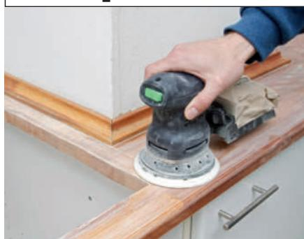
**1 Nå er det smart å fikse benkeplaten.** Her har den behov for å bli slipt helt ned. Det gjøres enklest med en eksenterslipper eller en planslipper. Er det hakk i platen, kan du starte med korn 60. Avslutt med korn 180.
