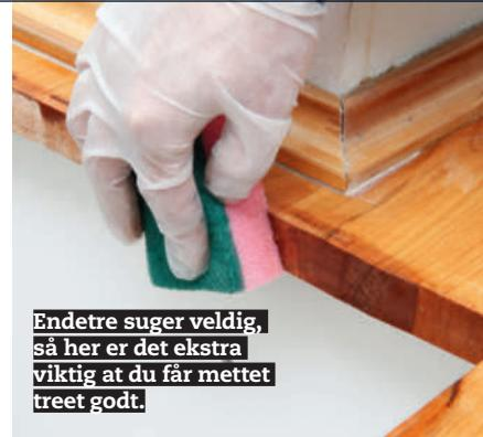
**3 Mett benkeplaten med olje, spesielt rundt i kanten, da endetre suger ekstra mye. Hell olje på platen, og arbeid det godt ned i overflaten med en skuresvamp. La platen suge til seg olje en halvtimes tid. Fjern det overskytende med en tørr klut.**
