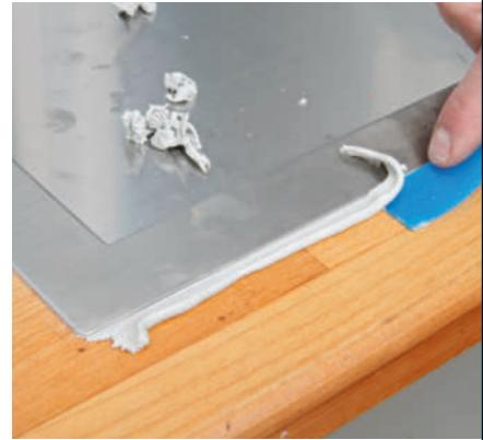
**4 Fjern overskytende sanitærkitt.** Bruk en plastskrape, slik at du ikke riper opp benkeplaten. Etterpå monterer du blandebatteriet til vannrørene og forbinder avløpet til vannlåsen.
