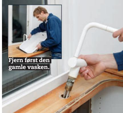
**1 Fjern blandebatteriet og den gamle vasken.** Iforkant skal du huske å stenge for vannet. Lukk også for ventiler, og demonter rørene til blandebatteriet. Vent med å avmontere blandebatteriet til du har fjernet vasken.
