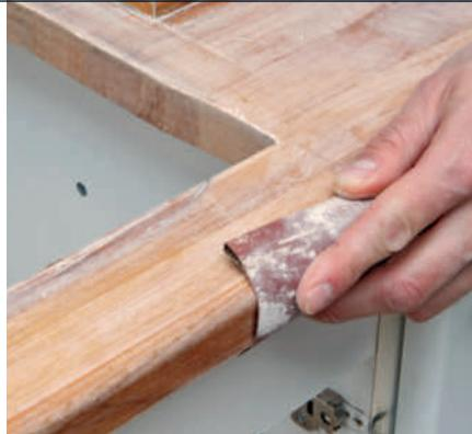
**2 Bruk slipepapir på forkanten.** Slip også listen mot veggen og helt ut i hjørnene av benkeplaten. Når du er ferdig, rengjøres platen for slipesstøv.
