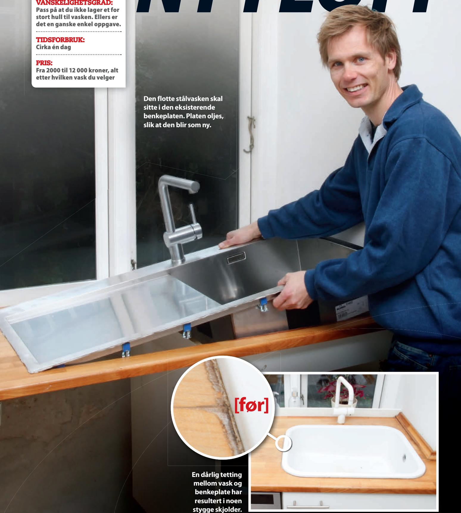
En dårlig tetting mellom vask og benkeplate har resultert i noen stygge skjolder.
