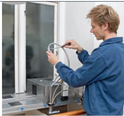
**1 Monter bunnventil og rør på vasken.** Legg den med bunnen i været, slik at du kan komme til. Monter også blandebatteriet.
