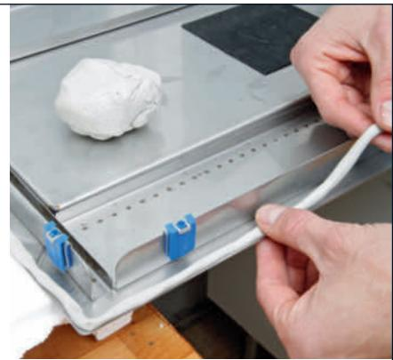
**2 Trykk fast en pølse sanitærkitt** hele veien rundt i kanten av vasken. Rull sanitærkittet mellom håndflatene, slik at det blir enkelt å forme. Bruk heller for mye enn for lite kitt.
