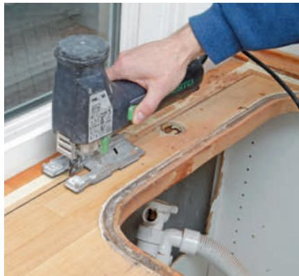
**4 Skjær hele veien rundt med en stikksag.** Bor først et hull på minst 8 mm rett innenfor streken i hvert hjørne, slik at du kan komme til for å sage. Pass på at du ikke treffer beslag på undersiden.
