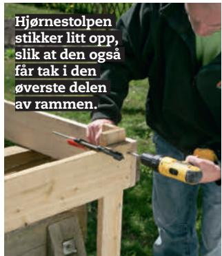
**4 Skru nederste del av rammen fast på hjørnene.** Når nederste del av rammen er satt sammen, fikseres hjørnene med tvinger mens du skrur dem med 5 x 60 mm skruer i forbored hull.
