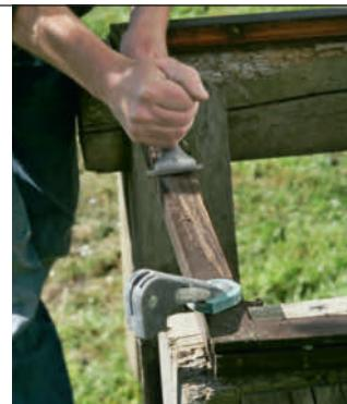
**2 Fjern løs maling på rammen.** Spenn fast vindusrammen på et stabilt underlag, og fjern all løs maling med et skrapejern. Deretter slipes rammen, slik at et nytt lag maling kan legges på.
