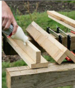
**2 Sett sammen hjørnestolpene.** De smale stykkene limes først med PU-lim og festes deretter med 5 x 60 mm skruer. Husk å forbore til skruene.
