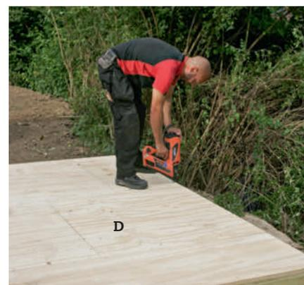
**7** Spikre fast resten av platene (D) med en spikerpistol med omkring 20 cm spikeravstand. Dermed har du en fin flate å reise veggene på.
