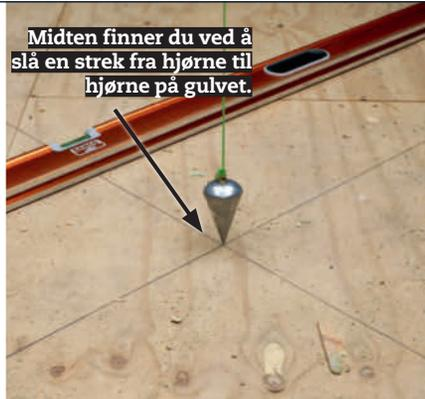
**1** Du skal henge en loddsnor over midten av gulvet. Legg opp en gradsperre (N) fra et hjørne inn mot sentrum, og understøtt den med et bord og en tvinge. Heng loddsnoren på den.
