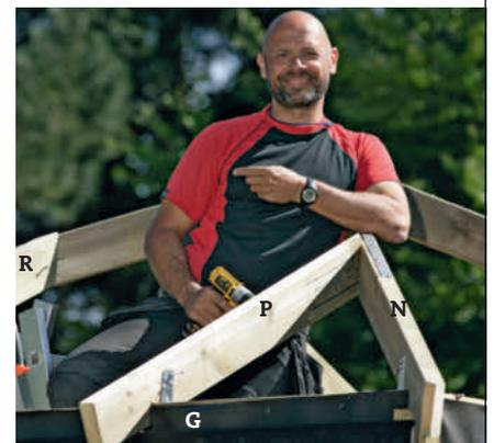
**8** Skru fast skiftsperrene (P og R) til toppsvillen (G) med vinkelbeslag. Skru skrått inn i gradsperrere (N).
