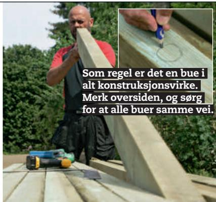
**1** Start med å “se ut bjelkene”. Ingen bjelker er helt rette. Derfor skal du begynne med å finne oversiden. Det vil si den siden der bjelken buer opp på midten. Marker den med en sirkel.
