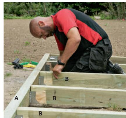
**5** Plasser resten av tverrbjelkene (B) i bjelkeskoene med oversiden opp, og sjekk at bunnen er i vinkel. Skru fast alle tilfarere i beslagene, og kloss dem opp på midten. Alle oppklossinger skrur fast til tilfarerne, slik at de ikke velter.
