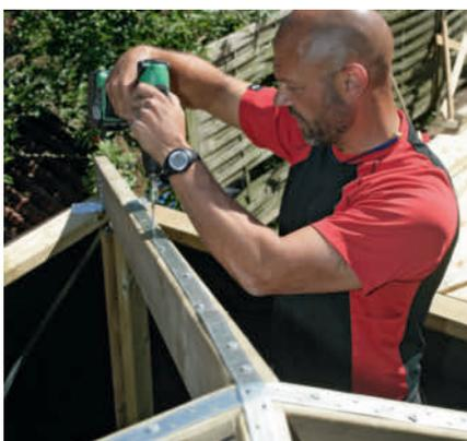
**6** Sett sammen gradsperrere (N) med hullbånd i et kryss over toppen. Du kan trekke dem helt tett sammen med en skrue som med vindkryssene. Nede på toppsvillen (G) holdes sperrene fast med et vinkelbeslag på begge sider.
