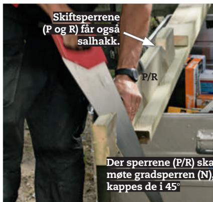
**7** Nå skal skiftsperrene (P og R) tilpasses. Begynn med å legge den korte sperren (P) vinkelrett på toppsvillen (G) 101 cm fra høyre hjørne, og den lange (R) 120 cm fra venstre hjørne. Strek opp der de skal kappes 45° etter gradsperrere.
