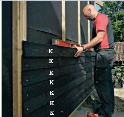
**1** Nå kan du sette bord (K) på fasaden. Det nederste bordet setter du etter en snor, som du spenner ut 9 cm over underkanten av bunnrammen. Avsett noen peilemerker på stolpene, slik at du får bordene til å flukte hele veien rundt.
