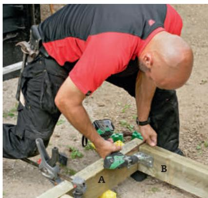
**4** Sett sammen rammen av bjelkene (A) og to tilfarere (B). Hvis bjelkene vrir seg, kan du spenne en tvinge på emnet. På den måten kan du utnytte vektstangprinsippet og vri treet, slik at du kan få det til å sitte som det skal.
