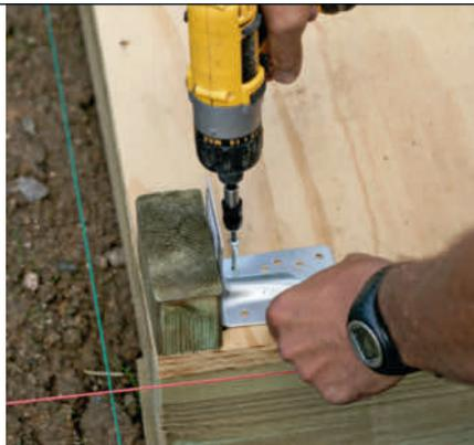
**1 Merk opp på gulvet, der stenderne (F) skal stå.** Skru deretter på vinkelbeslag med beslagskruer. Bruk en stolpebit på ca. 5-10 cm til å merke etter. Dørhullet (karmbredden + 15 mm luft i hver side) plasseres midt på den ene vegg.
