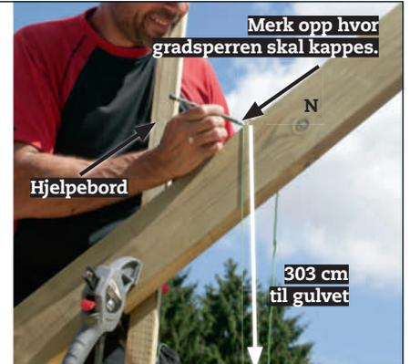
**2** Løft opp sperren (N), og flytt loddsnoren etter hvert som du løfter. Understøtt sperren med et bord og en klemtvinge som vist på bildet. Løft sperren og snoren til toppunktet er 303 cm over gulvet, og slå en loddrett strek på sperren.
