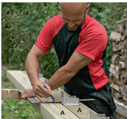
**3** Strek opp, og monter bjelkesko på bjelkene (A), slik at avstanden passer med at du kan skjøte gulvplatene på hver annen tilfarer. Det vil si 122 cm fra senter til senter – med en tilfarer midt på platen.
