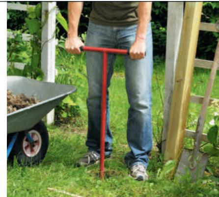
**2 Grav ut til stolpene.** Hullene skal være ned til frostfri dybde. I steinfri grunn er dette enkelt med et stolpebor.
