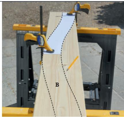
**1 Tegn opp buen (B) på bjelken.** Dette er enklest hvis du lager en pappmal du kan tegne etter. Sett fast malen på den ene halvdelen av buen, og tegn opp. Deretter speilvendes malen, slik at buen også overføres til den andre siden.
