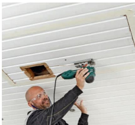
**5 Sag ut hullet med en stikksag.** I første omgang sager du noen centimeter innenfor strekene hele veien rundt, slik at hullet blir for lite.
