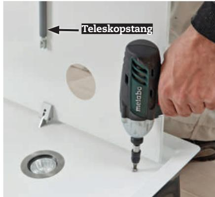
**1 Nå skal ventilatoren åpnes.** På ventilatoren sitter det en teleskopstang. Den frigjør du fra kassen, men la den sitte på glassdelen til frontplaten. Skru ut de fire skruene som holder fronten på kassen. Deretter kan fronten og kassen adskilles.
