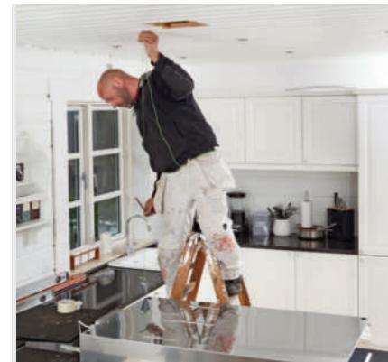
**4 Legg den nye ventilatoren med bunnen i været** på kokeplaten. Den skal flukte med forkanten på benken. Med loddsnoren overfører du de fire hjørnene til taket. Strek opp så hullet er 1 cm større enn kassen til ventilatoren i begge retninger.
