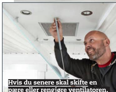
Hvis du senere skal skifte en pære eller rengjøre ventilatoren, vippes glassplaten ned. Teleskopstangen holder glasset på plass til du er ferdig.
