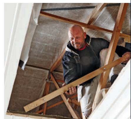
**6 Legg på plass plankene.** Be en hjelper om å gå opp på taket, slik at han kan legge på plass plankene før du, og enda en hjelper, løfter den tunge kassen til ventilatoren opp i hullet.
