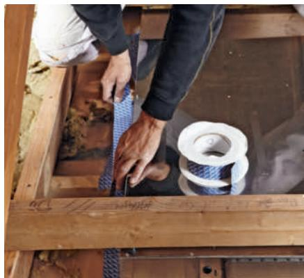
**4 Dampsperren tettes forsvarlig** med dampsperreteip mot sidene på ventilatoren. Etterpå isolerer du igjen med mineralull. Legg på like mye som du har på resten av loftet.
