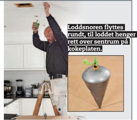
**1 Den nye ventilatoren bør sentreres over kokeplaten.** Marker midten med et kryss på et pappstykke. Du finner midten av kokeplaten ved å tegne diagonalt fra hjørne til hjørne.
