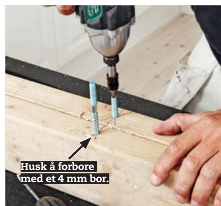
**5 Skru skruer i de merkene du har laget på plankene.** Her skal du bruke skruene som fulgte med ventilatoren. Skruene er formet som en fransk treskrue i den ene enden. I den andre enden er det maskingjenger og et stjernespor.
