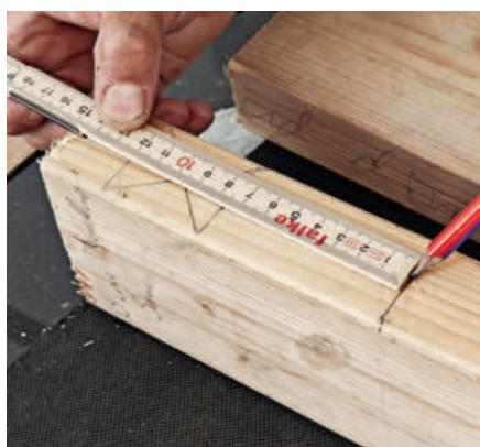
**4 Mål opp til skruene.** I topplaten til ventilatoren finner du de fire hullene du skal bruke når ventilatoren skal skrus fast til plankene. Mål avstanden mellom hullene. Denne avstanden markerer du på plankene, sentrert på dem.
