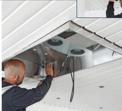
**1 Skru de medfølgende mutterne på maskingjengene til skruene** som stikker ned gjennom hullene i kassen. Husk å bruke spennskiver. Kontroller at alt sitter riktig før du spenner fast alle boltene. Dermed sitter ventilatoren fast.
