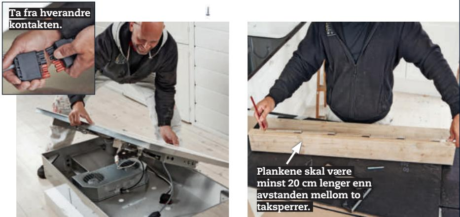
**2 Frontplaten løftes av** og settes et trygt sted, der den er beskyttet til du skal bruke den igjen.
