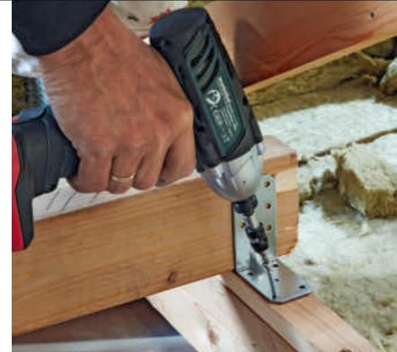
**2 De to plankestykkene skrus fast til taksperrerne** av sikkerhetsmessige hensyn, slik at de ikke senere veltes eller dyttes til siden. Bruk et vinkelbeslag på hver side av planken – fire til hver planke – og skru dem fast med montasjeskruer.
