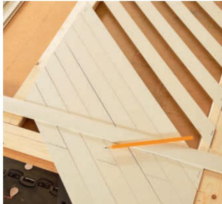
**3** Mål opp til de korte lamellene når de lange er på plass. Fyll ut resten av rammedeltet med lameller, og lag en strek på de lamellene som skal kappes. Kapp lamellene, og sett fast hver annen.
