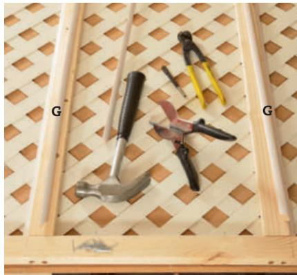
**6 Sett fast kvartstafflister (G og H)** på forsiden av rammen. Snu rammen rundt, og spikre fast kvartstafflister i kanten av feltene med 1,2 x 25 mm dykkert. Listene skjæres i 45 grader i endene, slik at du får en flott sammenføyning i hjørnene.
