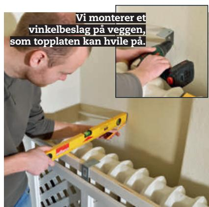
**3 Mål opp til topplaten (E).** Den skal støttes inn mot veggen. Mål vannrett ut fra overkanten av rammen, inn på veggen, og skru fast et vinkelbeslag.
