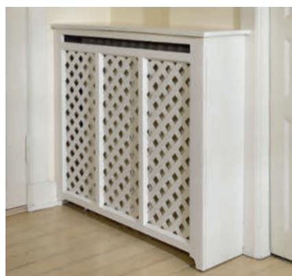
**5 Dermed er radiatorskjuleren på plass.** Den er tilpasset fotlistene nederst, og topplaten er saget til, så den passer til innhakket i veggen bak.
