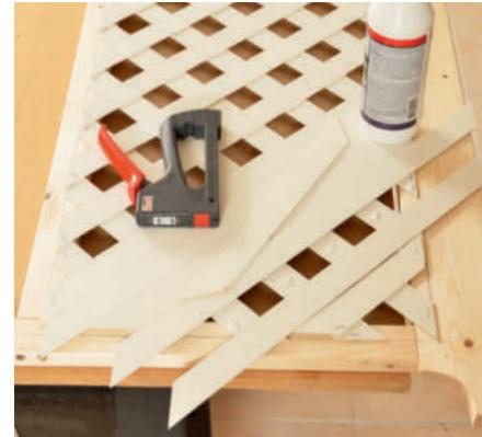
**5 Annet lamellag settes fast oppå** det første. Legg en kladd trelim på de lamellene i første lag som skal ha en lamell oppå seg. Sett fast lameller på samme måte i de resterende feltene på rammen.
