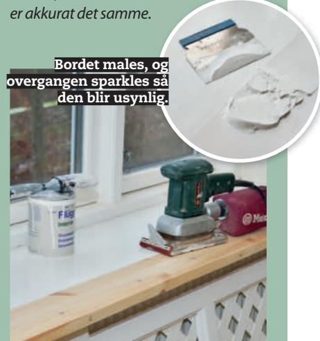
Vindusplaten lages dypere med et stykke limtre. Det skrus og limes fast med 5 x 100 mm skruer og slipes til.
