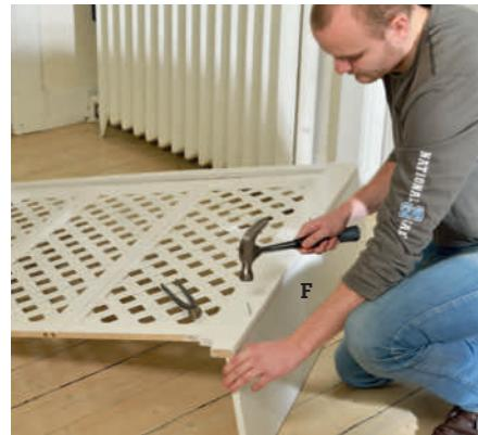
**2 Lim og spikre fast sidestykket (F)** til forrammen med 1,8 x 40 mm dykkert. Dermed er "kassen" klar til å bli satt på plass. Hvis radiatoren er frittstående, skal det være sideplater i begge sider.
