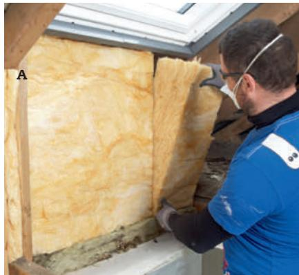
**6 Isoler bak og mellom stolpene (A)** med to lag 150 mm mineralull. Skjøtene forskyves mellom lagene.
