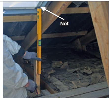
**1 Fjern isolasjonen mellom sperrene** i det området hvor hullet skal etableres. Bruk maske og hansker.
