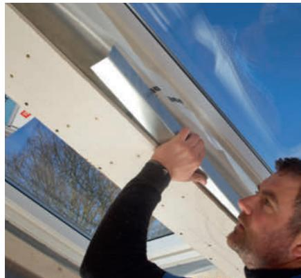
**3 Sett en stålinkel langs kantene i begge sider**, når du har fylt ut hulrommet med isolasjon. Vinkelen dyttes inn mellom gipsen og dampsperrerne. Skru den fast gjennom gipsen.
