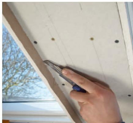
**6 Tilpass gipsplatene.** Gi sidene et snitt med hobbykniven langs bunnplaten, og brekk av kanten. Den siste finishen kan du klare med en gipshøvel.
