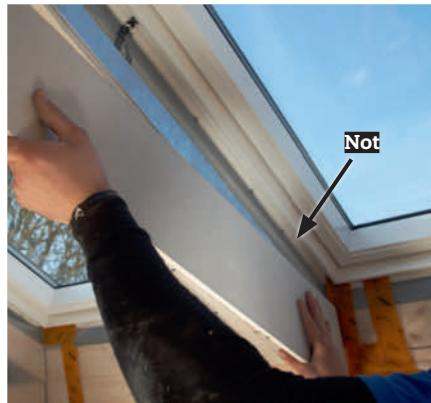
**4 Sett gipsplate på sidene.** Dytt først på plass dampsperrer. Både gips og dampspærre klemmes inn i noten i vinduet.
