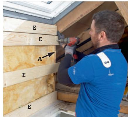
**7 Skru spikerslagene (E) vannrett på** stolpene (A og B) mellom sperrene i topp og bunn, og deretter minimum et bord for hver 45 cm mellom dem.
