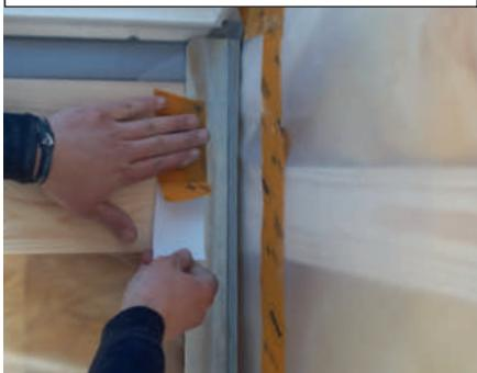
**1** Forsterk hjørnene på spikerslagene med stålvinkler. Klipp til fire vinkler, slik at de passer i lengden. Sett dem fast i hjørnene med dampsperreteip.
