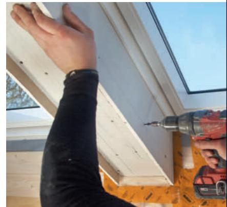
**5 Skru fast platene gjennom vinklene.** Trykk platen godt opp i noten, og skru den fast. Dampspærren kobles på dampsperrerne i begge ender med dampsperrteip.
