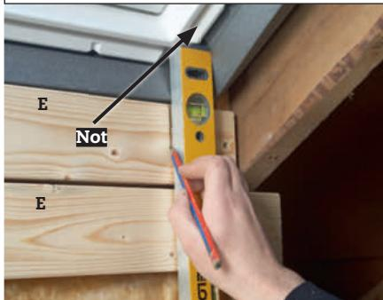
**1** Marker den innerste kanten av noten på spikerslagene (E). Hold et vater på kanten av noten, og marker på spikerslagene i begge sider, både på det loddrette og det skrå spikerslaget.
