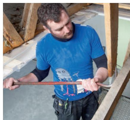
**4 Når du har skåret hull i taket etter markeringene, fjerner du de skrå stolpene på den midterste takstolen. De siste bitene av himling, spikerslag og stolpene på den midterste takstolen brytes av med et brekkjern.**
