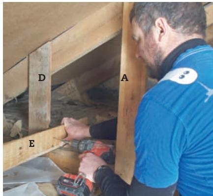
**4 Isoler under vinduet før** spikerslagene (E) monteres. Bygg først en enkel forskaling som plasseres 30 cm bak forkanten av stolpene (A). Det sikrer ventilasjon bak isolasjonen.
