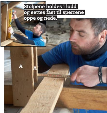
**2 Plasser de loddrette stolpene (A)** så langt inn at det er plass til spikerslag og gips mellom stolpen og ytterkanten på lysåpningen (kanten på hjelpebordet). Her er det i alt 35 millimeter.
