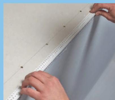
Det perforerte sparkelhjørnet limes fast, og beskytter kantene på gipsplaten.
