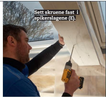
**1 Rett opp sperren** ved å skru et spikerslag (E) på begge sider. Bordene skjæres til med et skrått snitt i endene, og rettes inn slik at de har samme høyde og flukter med vinduene.
