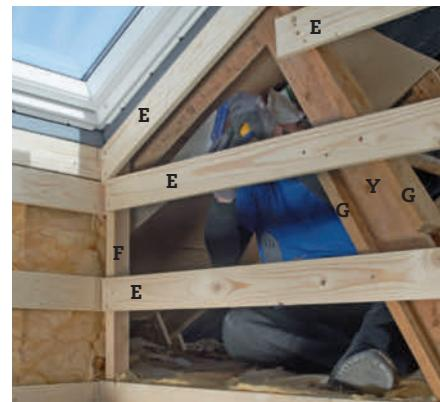
**5** Skru på de mellomliggende spikerslagene (E) med maks. 45 cm mellom. Understøtt dem med støttebord (G), som skrus på på takstolen (Y).
