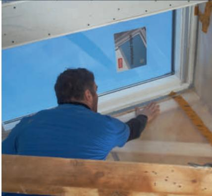
**2** I sidene skjæres gipsplatene på skrå. Mål opp, og bruk en smygvinkel og en lang rettholt når mål og vinkel skal overføres til gipsplatene.
