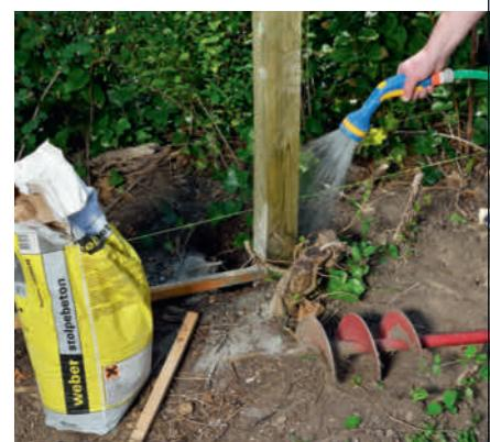
**7 Tøm på enda en halv pose stolpebetong,** mer jord, stamp godt, og vann rundt stolpen. La betongen tørke et døgn tid, før du monterer modulene. Hvis du ikke vanner, må du vente en uke.
