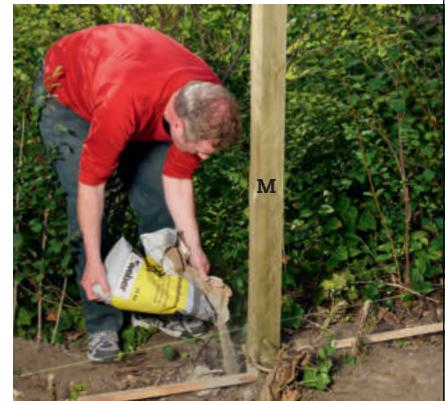
**5 Tøm stolpebetong (N) ned til stolpen.** En halv pose ferdigblandet stolpebetong er passe. Du trenger ikke å helle på vann; bakkens fukt er nok.
