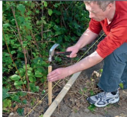
**1 Spenn ut en snor der veggens skal stå.** Bruk trepinner. De bankes så langt ned at de kan holde snoren stram. Bind fast murersnor 20-25 cm over bakken.
