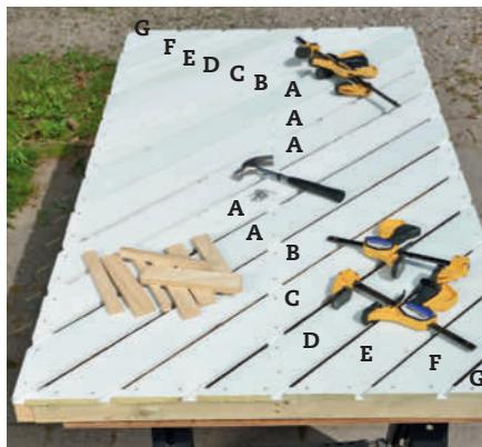
**6 Fyll ut med de øvrige bordene.** Lengden på bordene viser deg hvor de skal ligge. Avstanden sikrer du med avstandsklossene. Etterpå er det bare å spikre på bordene og male kanter.
