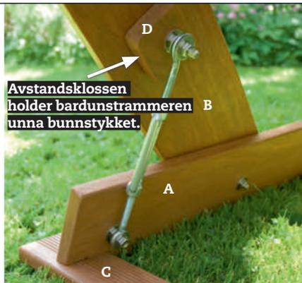
**1 Stativet holdes sammen med bardunstrammere i hjørnene,** og bolter med muttere og spennskiver i bunn og topp. Sett stativet løst sammen først, og spenn til alle bolter til slutt.
